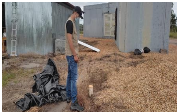
Figura 14 Inspección de caja de entrada al sistema de tratamiento.
