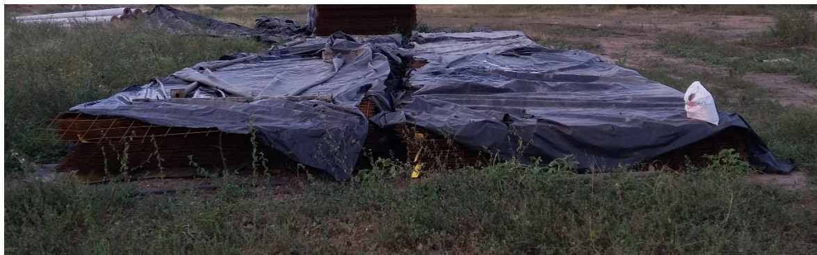
Img. 26 Punto de acopio material de tubería
