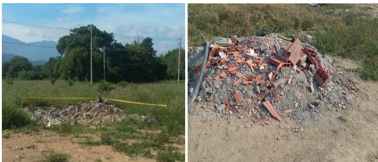
Img. 17 Punto de acopio de escombros
