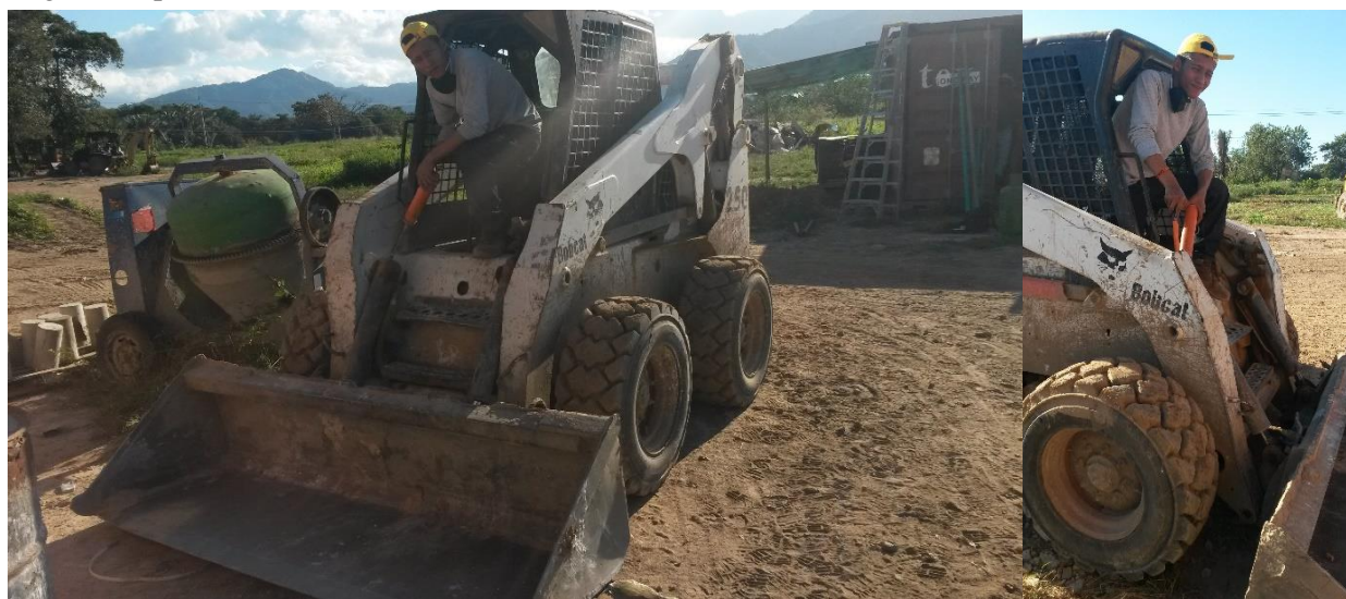
Img. 39 Inspección diaria
