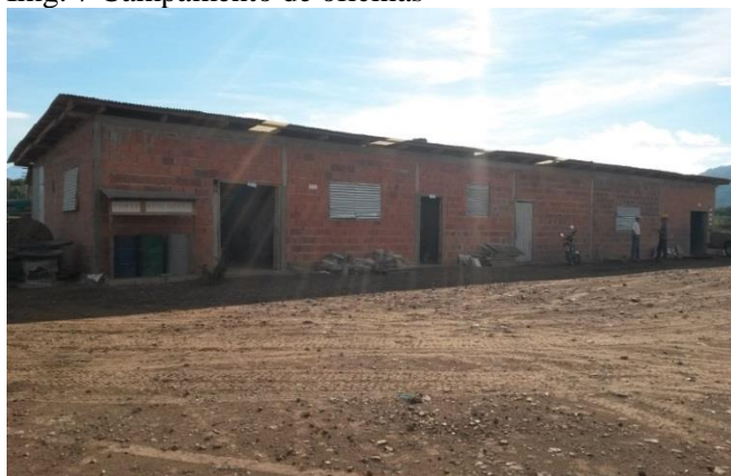
Img. 7 Campamento de oficinas
