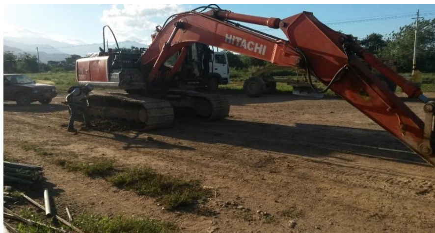
Img. 40 Limpieza de maquinaria
