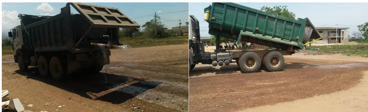
Img. 46 Área de maquinaria estado inicial
