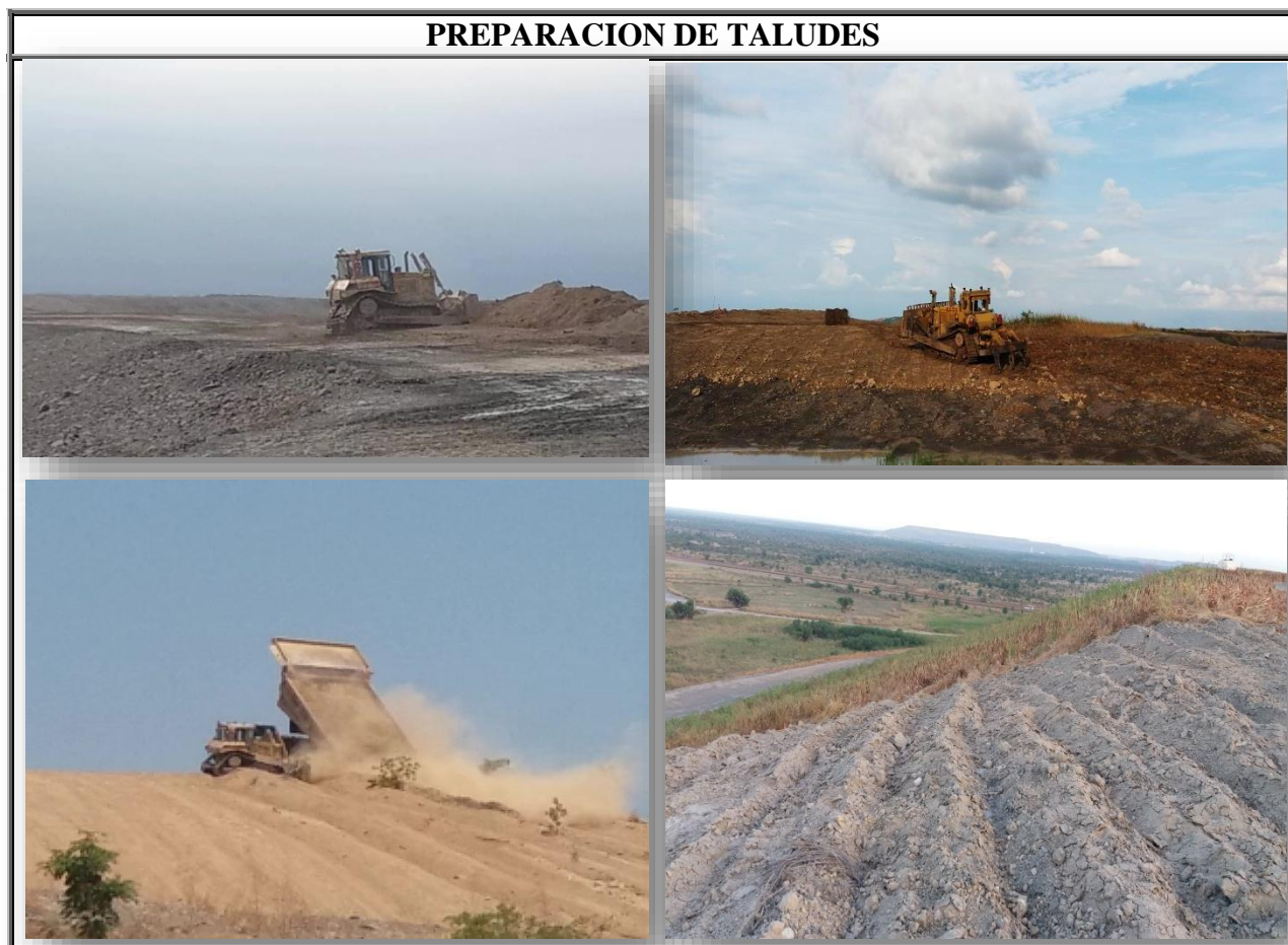
Fotografía 14. Actividad de preparación de taludes.
