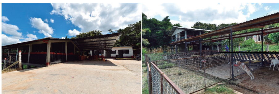
Figura 11. Vista general del aprisco. A la izquierda aprisco elevado con zona de manejo y área administrativa, a la derecha aprisco en suelo con zona de sombra y sol y bebedero automático
