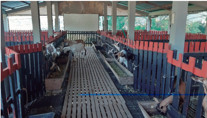
Figura 19. En el diseño de este aprisco elevado se proyectó la ventilación necesaria para el bienestar de los animales y el uso de cortinas para mejorar las condiciones ambientales dependiendo la época del año
