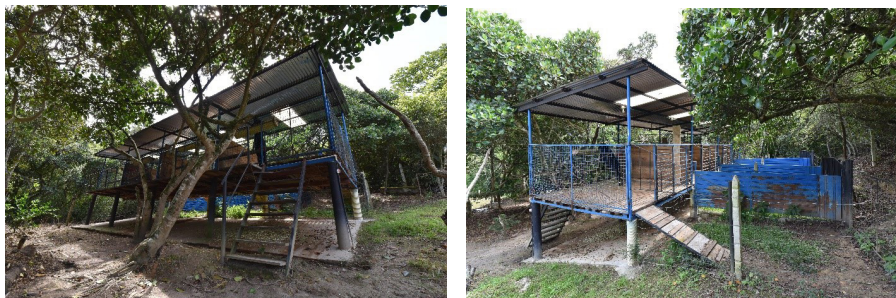
Figura 22. Área individual para machos. A la izquierda escalera para ingreso de personal, el diseño de este aprisco es elevado. A la derecha el aprisco cuenta con rampas de acceso, zona techada y en tierra, comedero, saladero y bebedero automático
