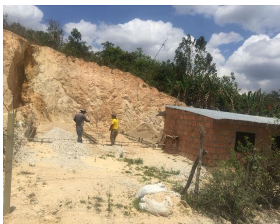
Construcción de una vivienda del proyecto de VISR
