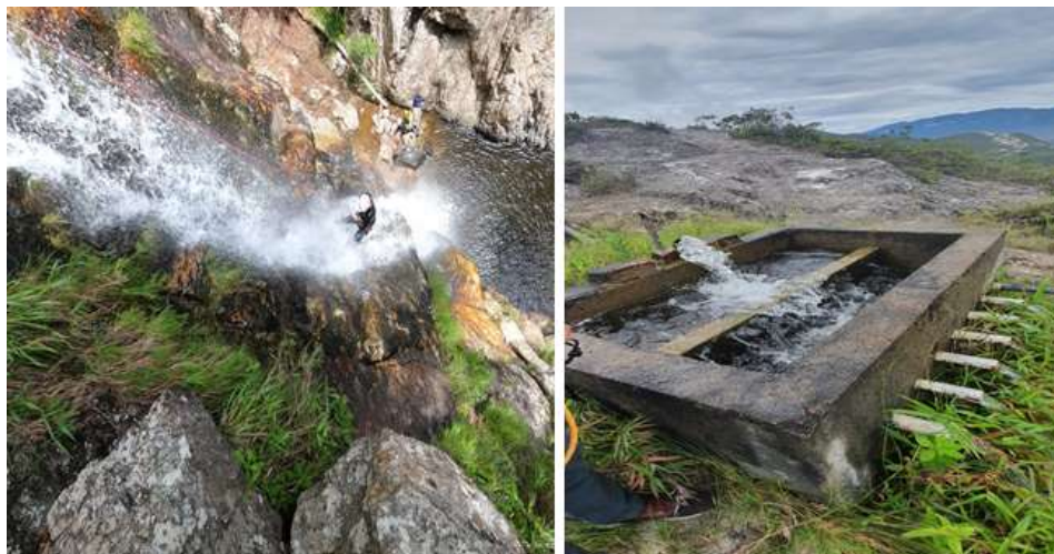
Figura 8. Evidencia del día de la visita en predio La Vieja y la tanquilla de reparto. Fuente. Autor del proyecto
