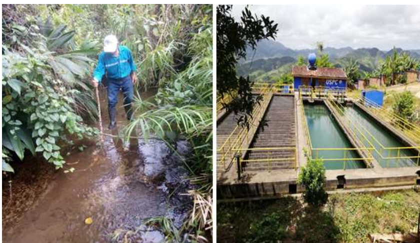
Figura 16. Aforo en la entrada de la PTAP de convención.
