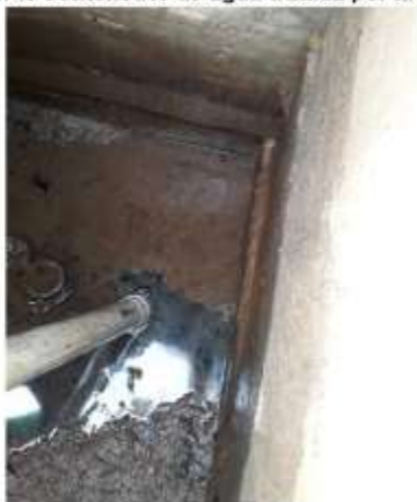
Imagen 3. Contenedor de agua tratada por la trampa.
