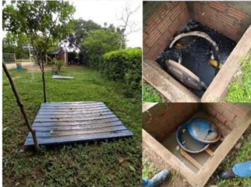
Imagen 12. Contenedores temporales de aguas residuales averiados. Disposición Final PTALB.
