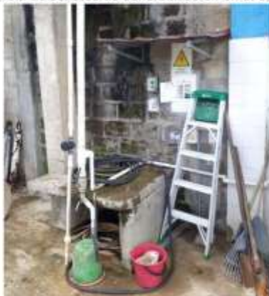
Imagen 4. Ausencia de señales de sensibilización en el espacio de lavado.
