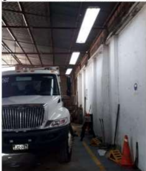
Imagen 3. luminarias encendidas en horario no laboral.
