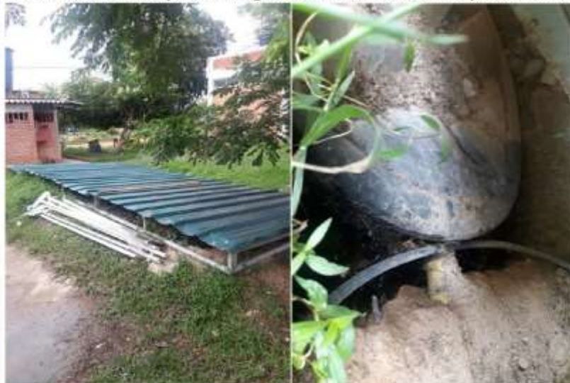
Imagen 12. Contenedores temporales de aguas residuales averiados. Disposición Final PTALB.
