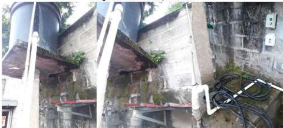
Imagen 7. Plataforma tanque elevado.
