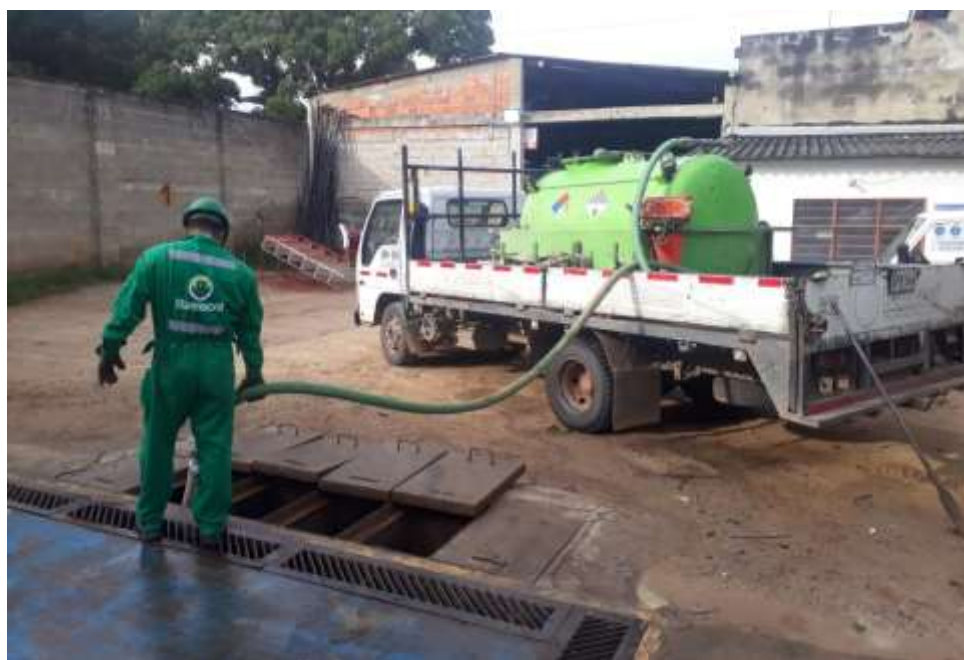
Figura 13. Aseo industrial, succión trampa de grasas. Autor, 2020
