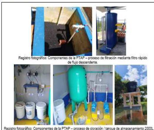
Registro fotográfico: Componentes de la PTAP – proceso de filtración mediante filtro rápido de flujo descendente.
