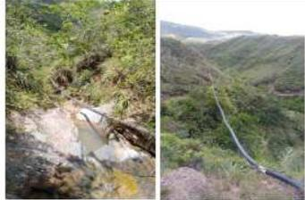
Registro fotográfico: conducción al tanque de almacenamiento mediante manifiesto de alta presión de 4" y 3".
