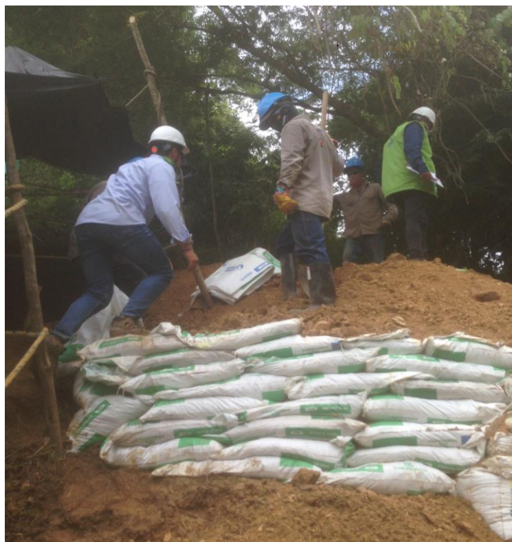
Figura 32. Trinchos para estabilizar el deslizamiento de tierra. Autor del proyecto.
