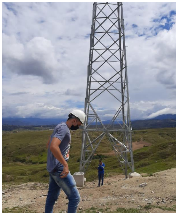
Figura 25. Visita a torre finalizada. Autor del proyecto.
