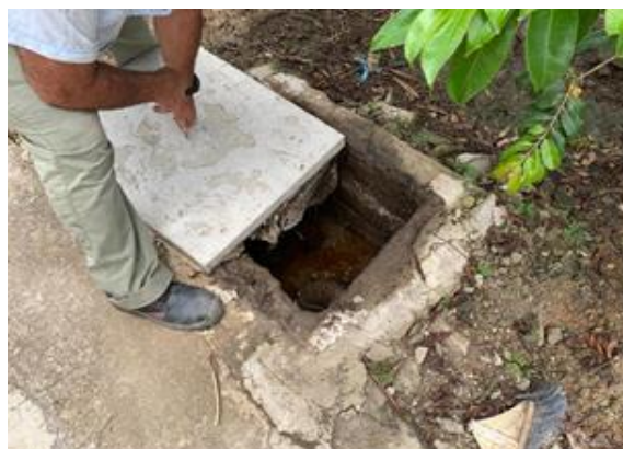
Figura 10. EDS Los mangos. Autor del proyecto. Figura 11. Trampa de grasas. Autor del proyecto.
