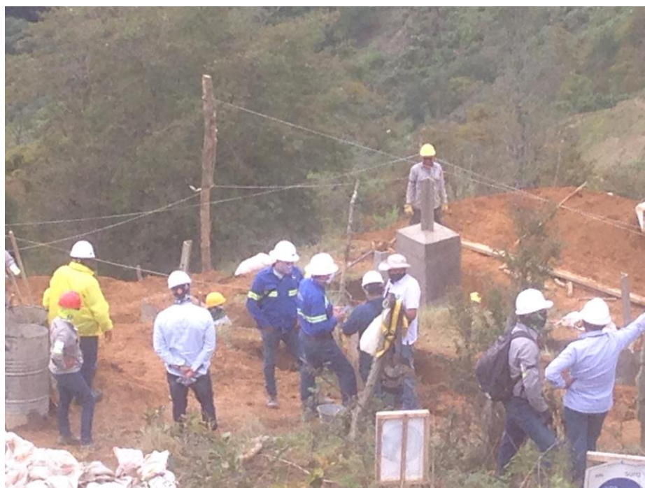
Figura 34. Visita de seguimiento a construcción de la torre 56. Autor del proyecto.
