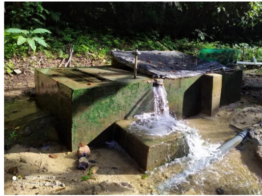
Apéndice I. Tuvo de desfogue y sedimentador parte alta. Pasante.
