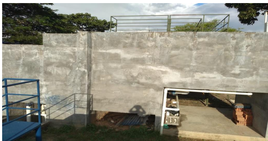
Figura N° 16. PTAP corregimiento la pedregosa. Pasante
