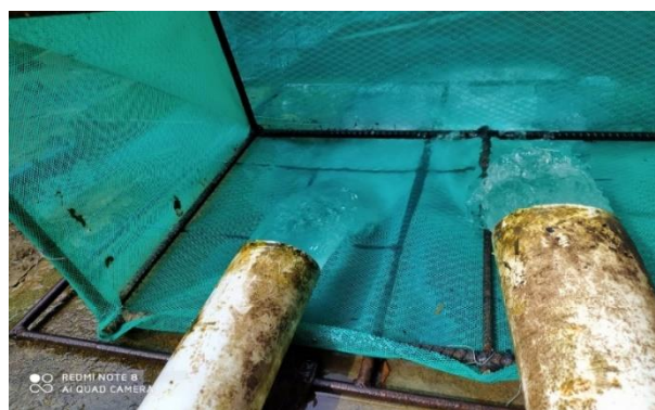
Apéndice E. Cambio de malla que retiene los sólidos y partículas de gran tamaño. Pasante.
