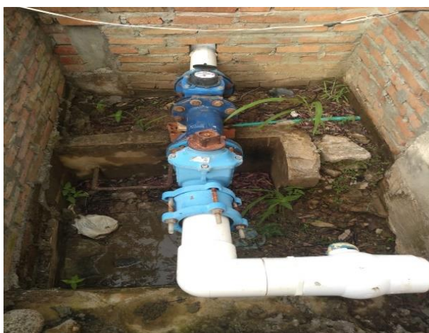
Figura N° 22. Salida a la red de distribución. Pasante
