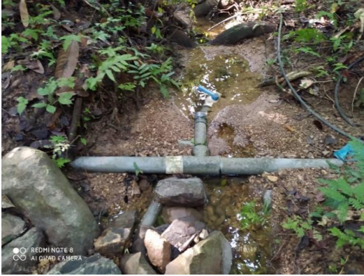
Apéndice I. Tuvo de desfogue y sedimentador parte alta. Pasante.
