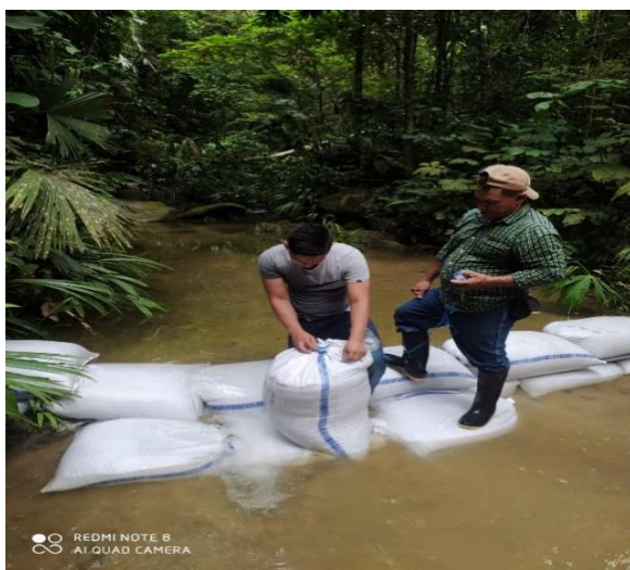
Apéndice D. Muro de contención en costales y material pétreo por arrastre del río. Pasante.
