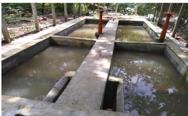
Figura N° 14. Desarenador acueducto la pedregosa. Pasante
