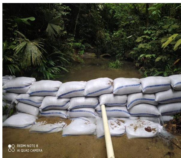
Apéndice D. Muro de contención en costales y material pétreo por arrastre del río. Pasante.
