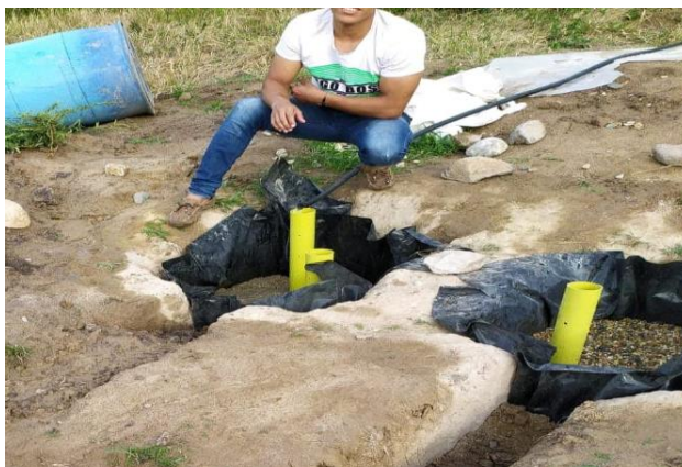
Imagen 8. Filtros de la primera y segunda etapa del sistema piloto. Fuente: Autores del proyecto)
