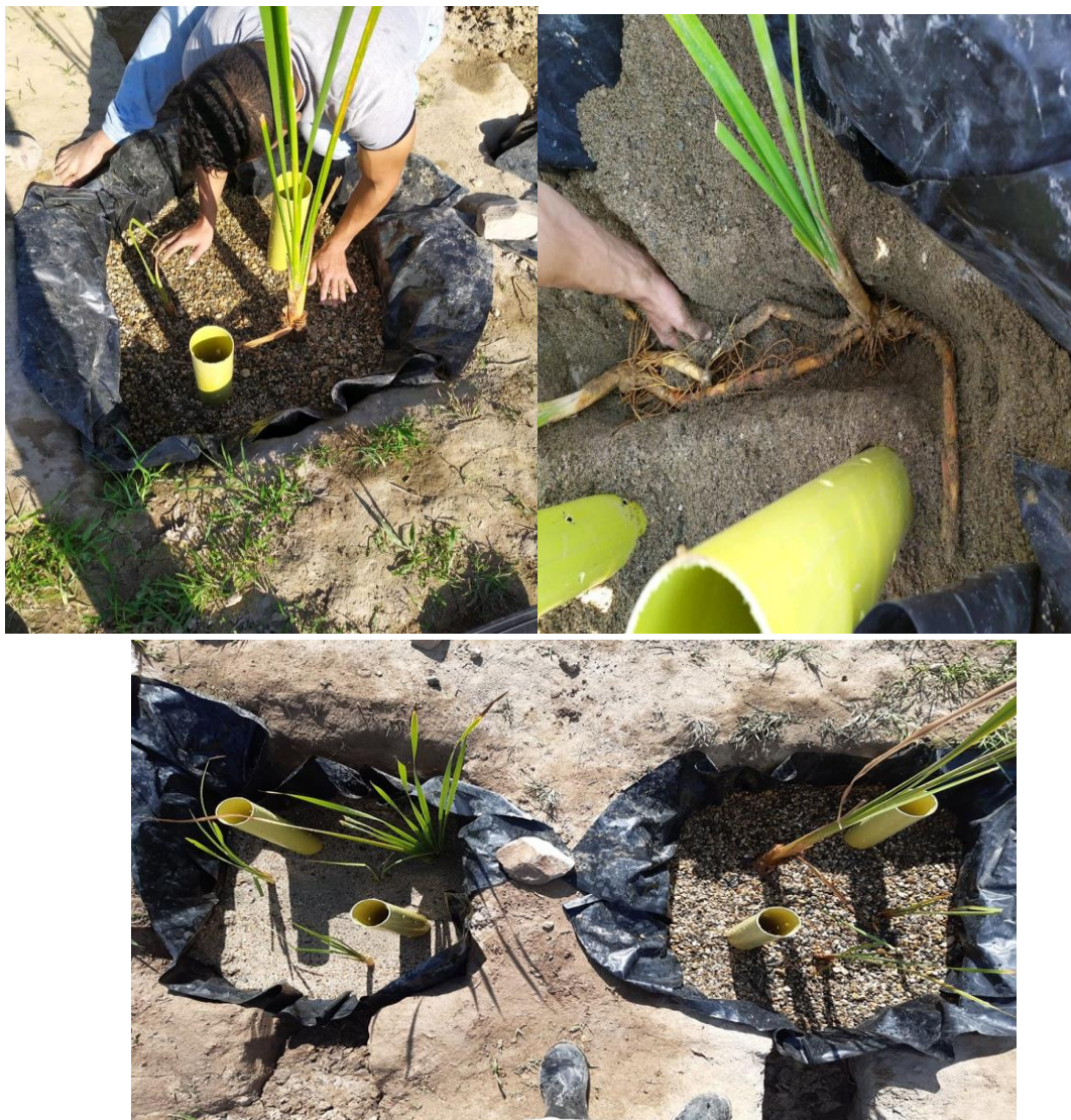
Imagen 12. Plantación de la especie typha latifolia (totoras) en los filtros de la primera y segunda etapa del sistema. Fuente: (Autores del proyecto)
