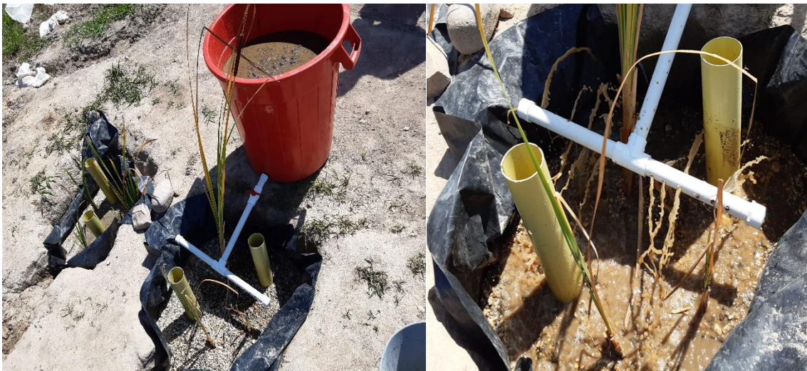
Imagen 14 Dosificación de las aguas residuales en el filtro de la primera etapa del sistema piloto. Fuente: (Autores del proyecto)
