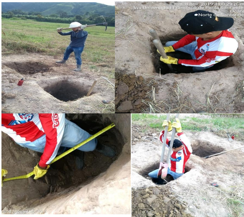
Imagen 1. Dimensiones de 0.75m*0.75m del primero y segundo filtro del sistema piloto con profundidades de 1.40m y 1.20m. Fuente:(Autores del proyecto)
