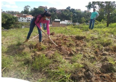
Figura 32. Adecuación del terreno. (2021).
