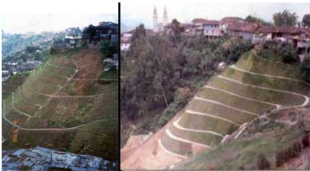
Figura 14. Ejemplo de abancalamientos típico (Comuna 2 – Manizales y Municipio de La Merced). Fuente: file:///C:/Users/Sergio/Downloads/corpocaldasobras.pdf
