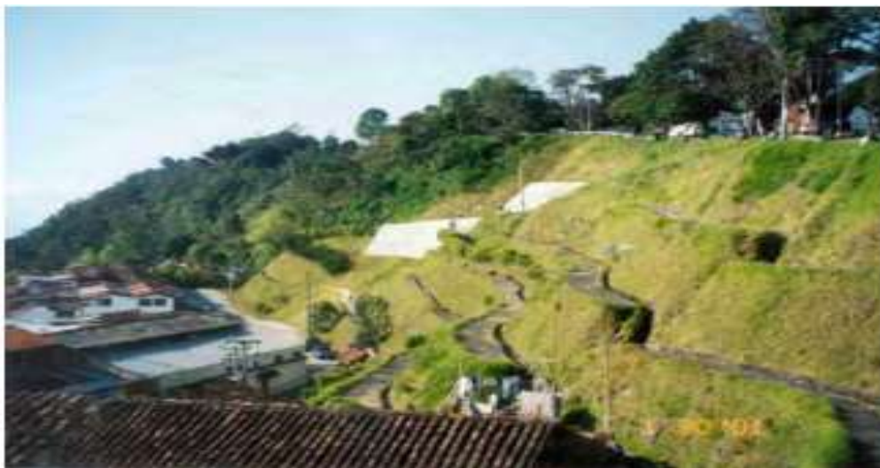
Figura 16. Tratamiento tpico con zanjas colectoras.
