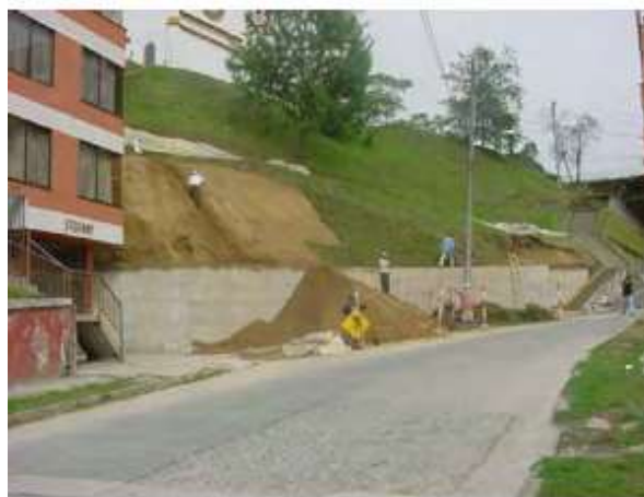
Figura 20. Muro de contención en ciclópeo
