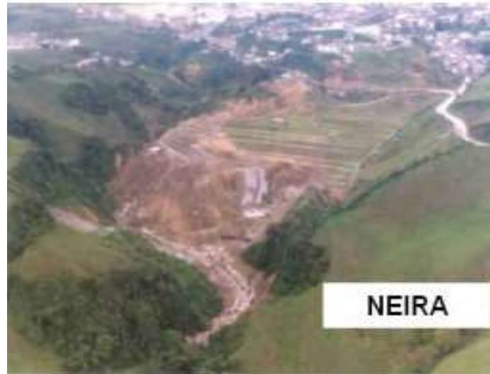
Figura 18. Canalización de cauce con gaviones
