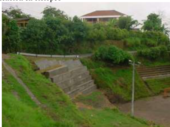
Figura 20. Muro de contención en ciclópeo
