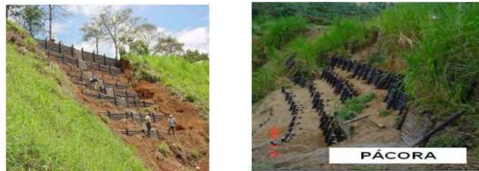
Figura 15. Ejemplo trinchos en guadua
