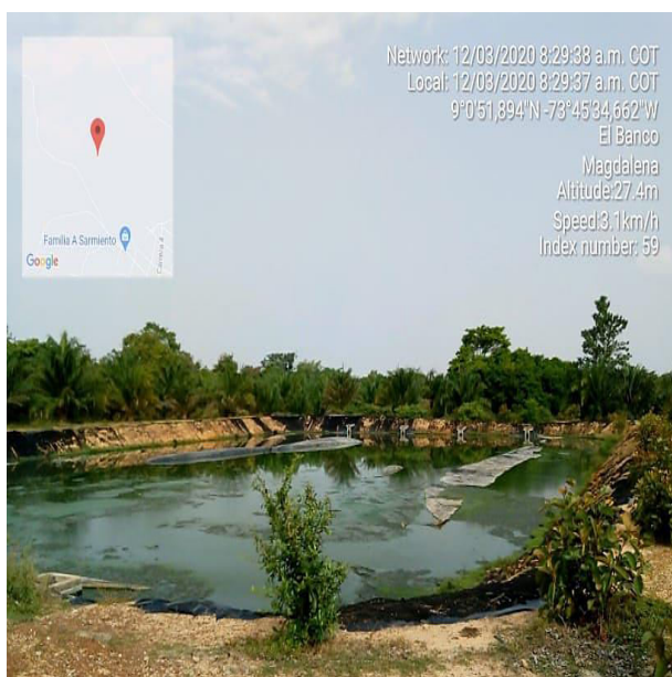
Figura 11. Fotografía laguna de oxidación cubierta en poca extensión por la geo membrana. 12 de marzo de 2020 Fuente: Autores (2020)
