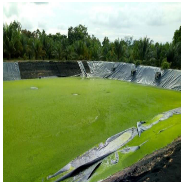
Figura 9. Fotografía de la laguna de oxidación cubierta por la geo membrana el 20 de abril 2019. Fuente: Autores (2020)
