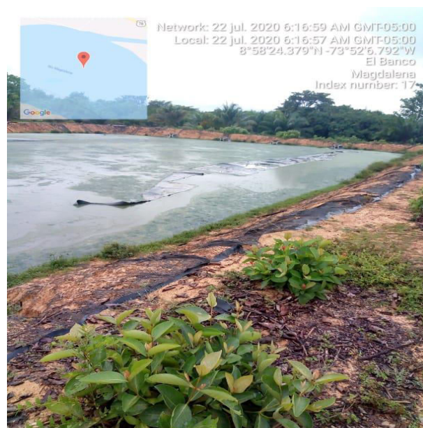
Figura 10 Fotografía laguna de oxidación cubierta solo en el fondo por la geo membrana. 22 de julio de 2020 Fuente: Autores (2020)
