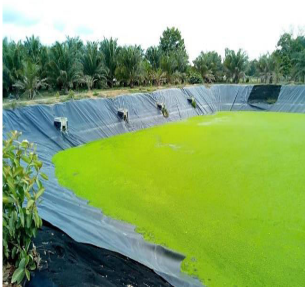
Figura 8. Fotografía de la laguna de oxidación cubierta por la geo membrana el 20 de abril 2019. Fuente: Autores (2020)
