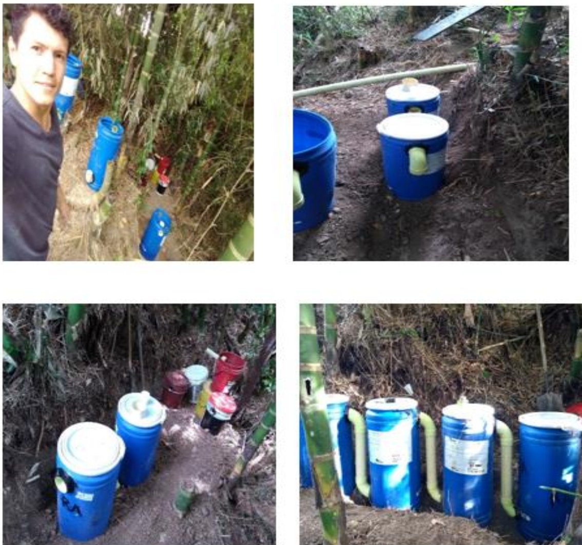
Figura 16. conexión de cada uno de los tanques de 60 L con la tubería correspondiente de 3 pulgadas Fuente: Autores de la investigación, 2020.
