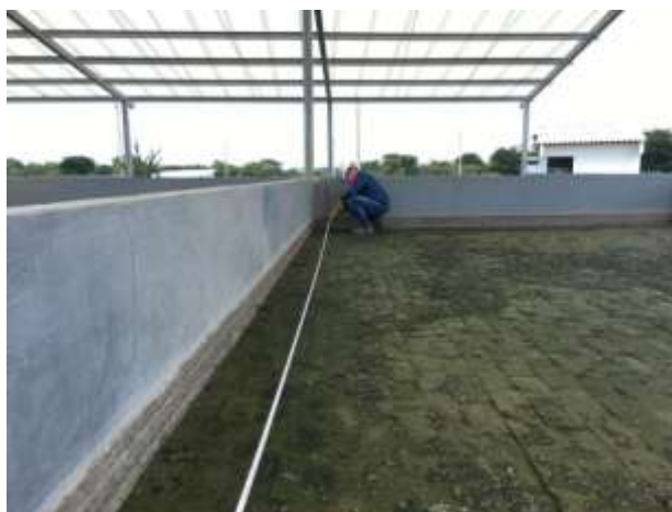
Figura 32. Toma de medidas de los tanques
