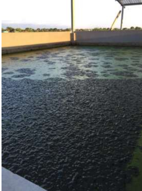
Figura 26. Acumulación de espesor de los lodos
