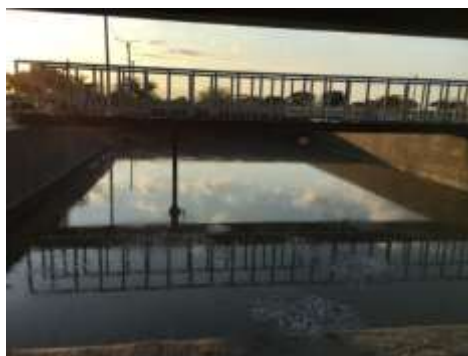
Figura 17. Sedimentador primario
