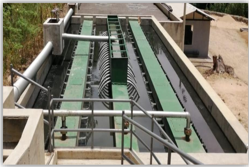
Figura 10. Reactor UASB. Fuente: Autores del proyecto.
