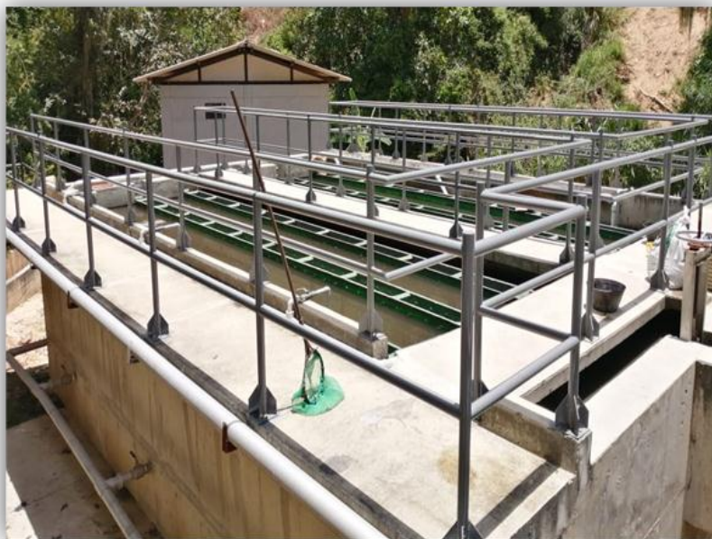
Figura 13. Sedimentador. Fuente: Autores del proyecto
