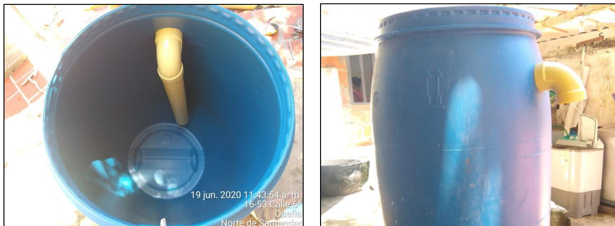
Figura 18. Instalación de la tubería de descarga del digestor. Autores, 2020.
