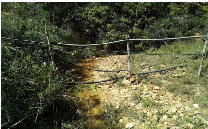
Figura 52. Red de Distribución por gravedad, mediante mangueras.
