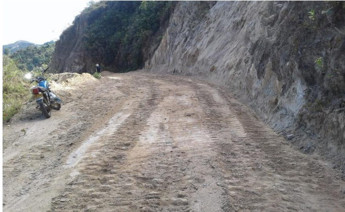
Figura 11. Mantenimiento a la vía terciaria del Corregimiento la María.
