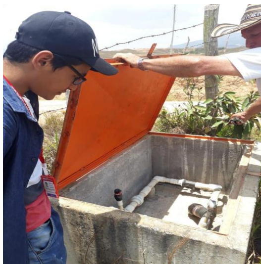
Figura 34. Bomba Hidroneumática utilizada para la captación de agua.
