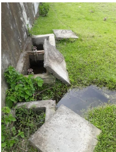
Figura 47. Llaves de paso del tanque primario a la red de distribución
