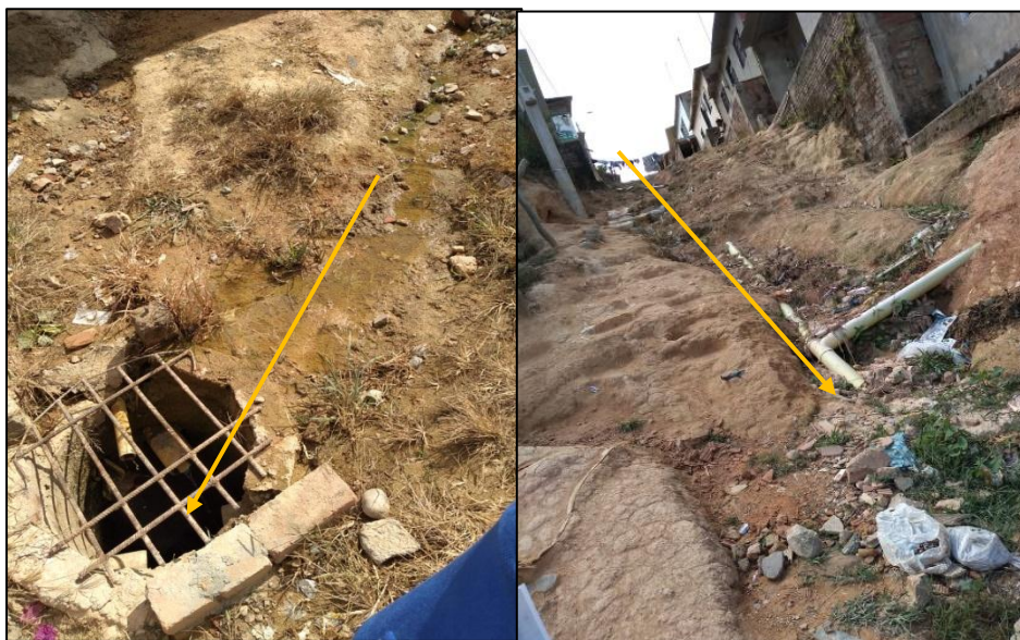
Figura 14. Alcantarillado provisional barrio Colinas de la provincia
