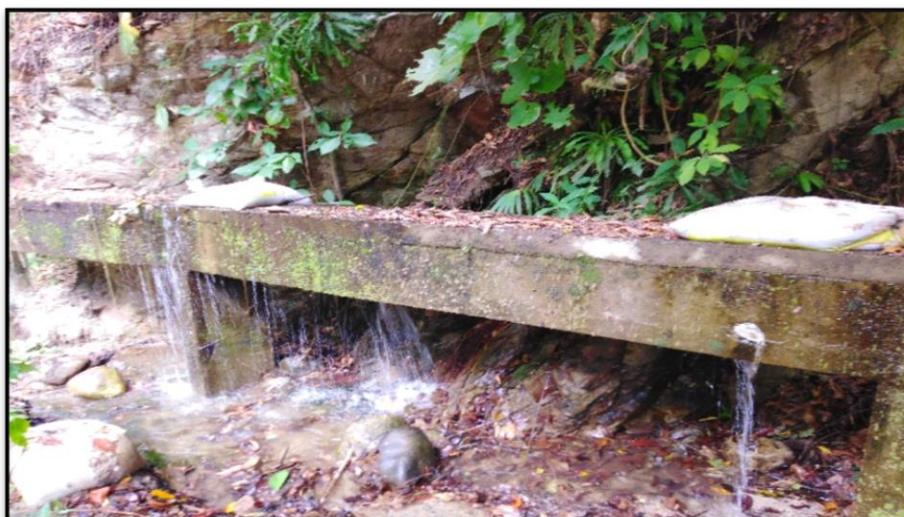
La figura 26 muestra la tubería de aducción la cual se encuentra construida en concreto y tiene una longitud de 270 mts aproximadamente desde la bocatoma hasta el desarenador. Se observa por la imagen, que la estructura presenta actualmente un deterioro evidente, situación que impide la correcta distribución de agua hacia el desarenador.
