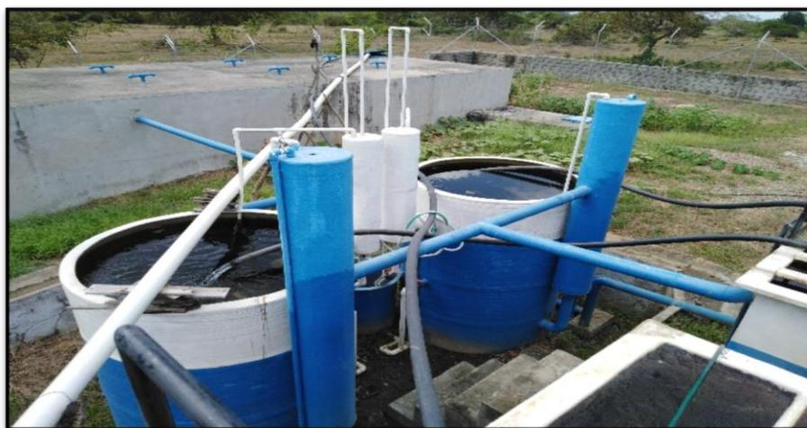
La figura 30 muestra los filtros de gravedad que hacen parte de la planta de tratamiento de agua potable, pero estos no se encuentran operando de manera correcta debido a que no se cuenta con el personal y los insumos adecuados para su funcionamiento.
