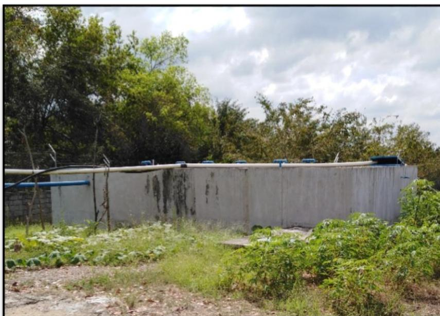
La figura 31 muestra el tanque de almacenamiento de agua, que hace parte de la planta de tratamiento de agua potable. Se puede evidenciar que muestra deterioro de su infraestructura física y que sus alrededores están descuidados y por tanto hay plantas creciendo sin control. Actualmente, el tanque no está operando al máximo de su capacidad.
