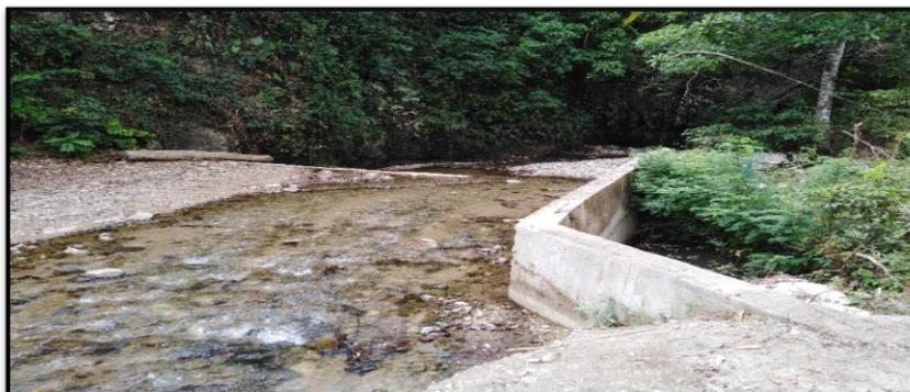
En la figura 24 se puede apreciar la bocatoma que hace parte del sistema de acueducto de los corregimientos, a través de la cual se hace la captación del agua que se distribuye al sistema. Se puede evidenciar que la estructura de concreto muestra un poco de erosión, debido a que no recibe los mantenimientos adecuados.
