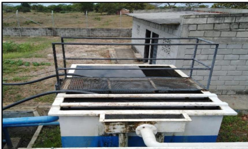
La figura anterior, muestra el sedimentador que hace parte de la planta de tratamiento de los dos corregimientos. Se evidencian signos de deterioro por oxidación. Actualmente, no está operando de manera óptima, debido a que no se cuenta con los insumos y personal necesario.
