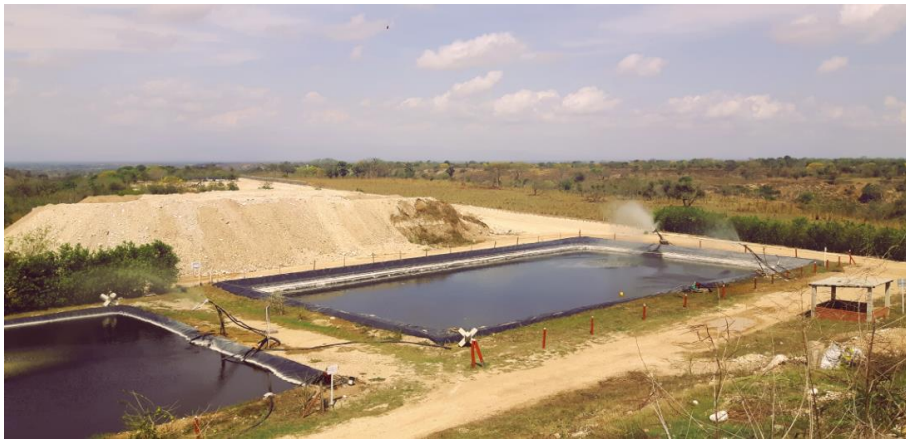
Fotografía 9. Piscinas de almacenamiento de lixiviados.
