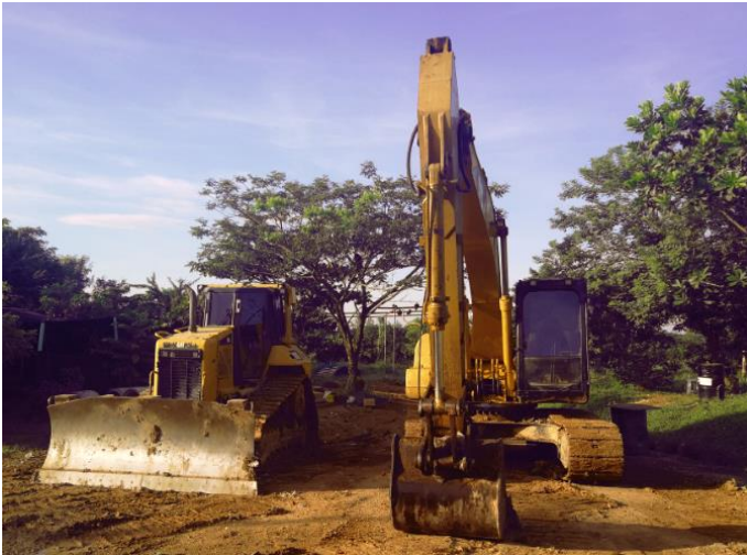
Fotografía 15. Maquinaria pesada en actividades de compactación y cobertura.
