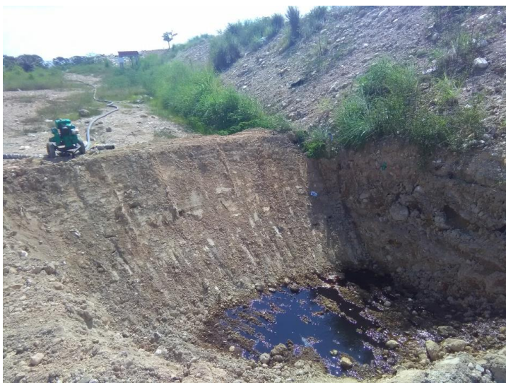
Fotografía 25. Pozo provisional con motor y tubería instalada para bombeo de lixiviado a piscinas.
