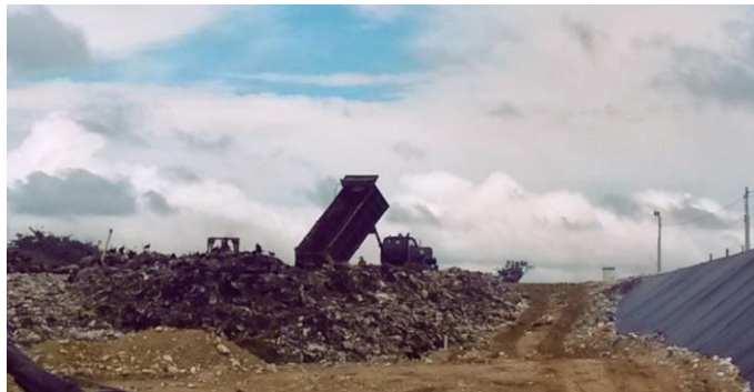
Fotografía 13. Descargue de residuos en el frente de trabajo.
