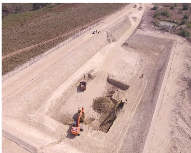
Fotografía 1. Construcción de celda de operación.
