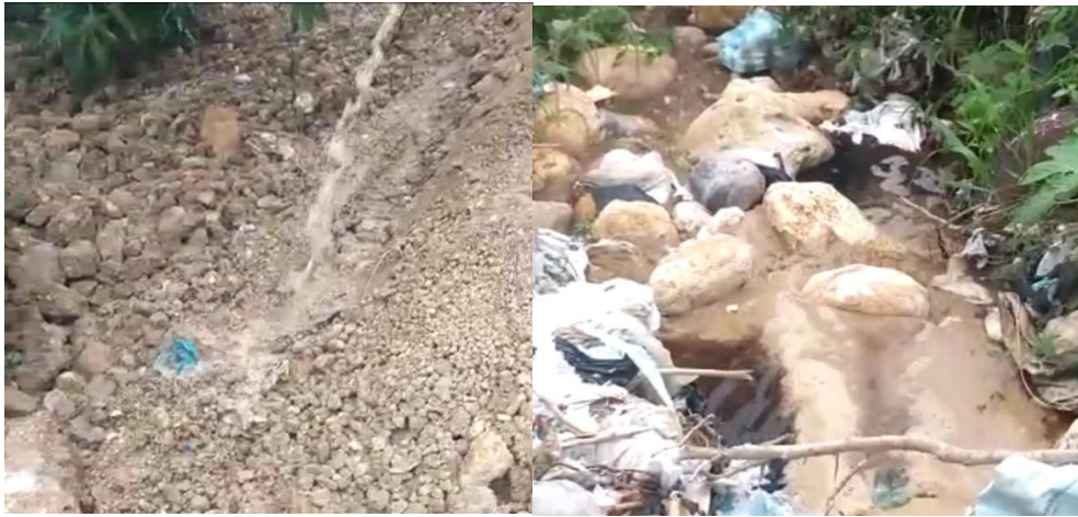
Fotografía 26. Bombeo de agua hacia la cañada.
