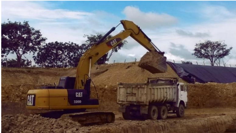
Fotografía 5. Extracción y transporte del material de cobertura diaria.
