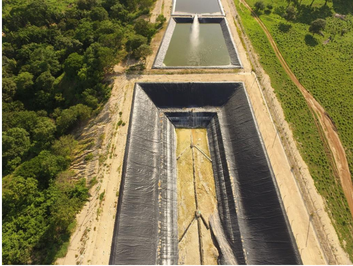
Fotografía 1. Impermeabilización de la celda de operación y piscina de lixiviado. Fuente: Autor del proyecto.
