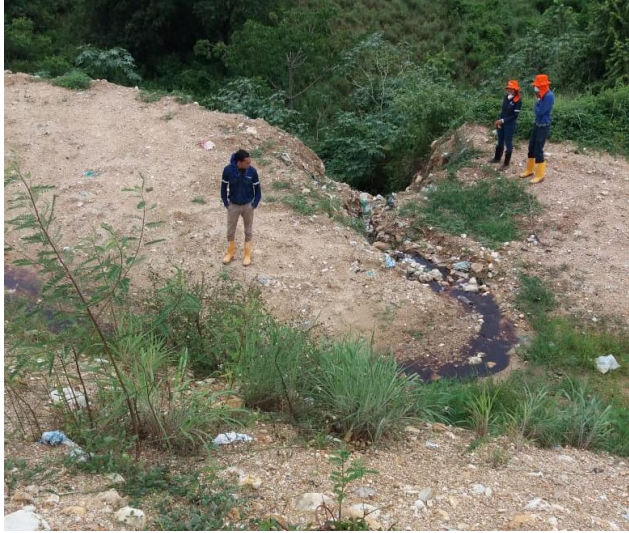
Fotografía 22. Vertimiento de lixiviados sobre la cañada. Fuente: Autor del proyecto.
