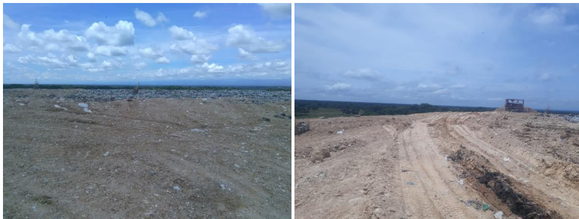
Fotografía 28. Cobertura de residuos sólidos expuestos en plataforma.
