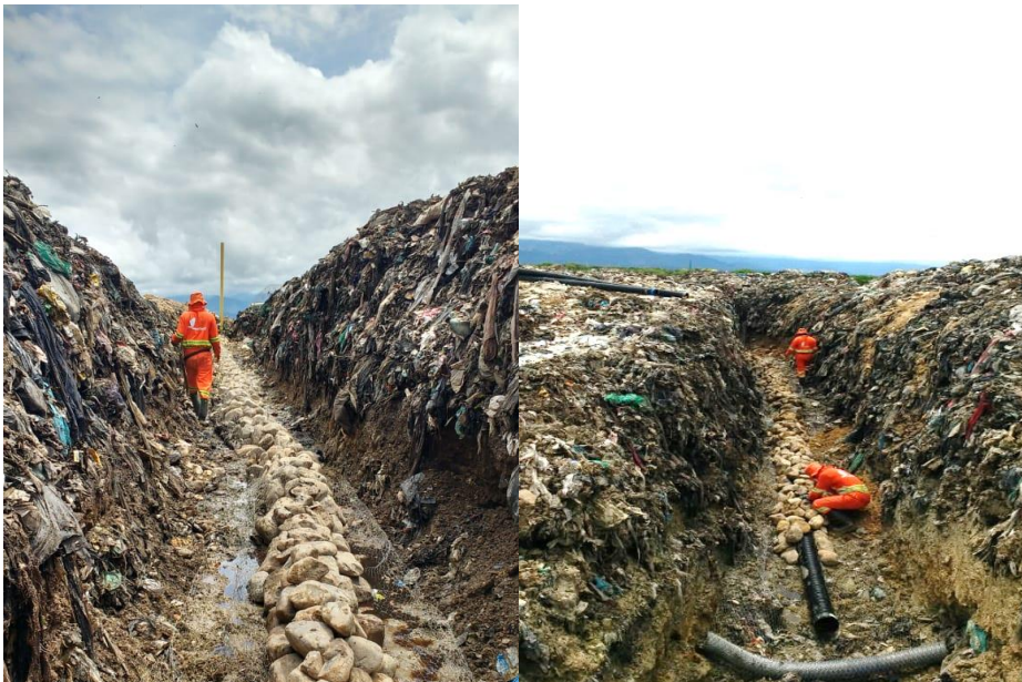
Fotografía 27. Construcción de filtro en celda afectada por lixiviados.
