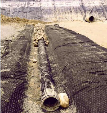
Fotografía 7. Construcción de filtros para la recolección y conducción de lixiviados.
