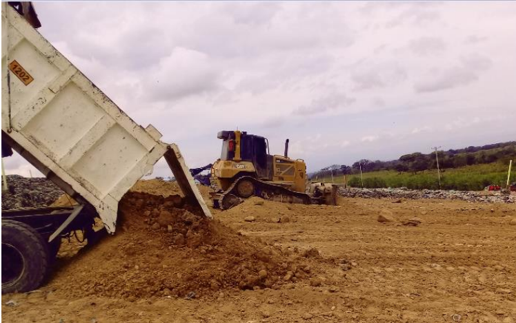
Fotografía 14. Descargue, tendido y compactación del material de cobertura.
