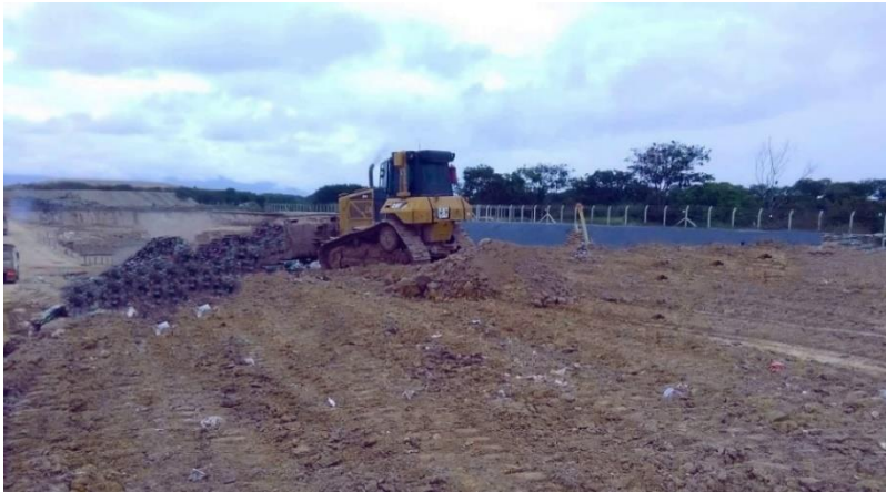
Fotografía 4. Proceso de compactación efectuada por la maquinaria pesada.
