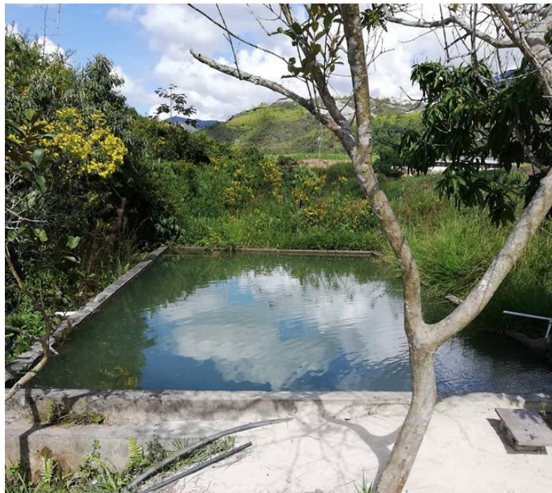
Ilustración 6. Tanque de almacenamiento para el sistema de riego. Fuente: pasante
