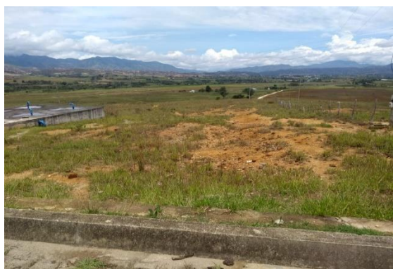
Foto 19. Tanques de almacenamiento
