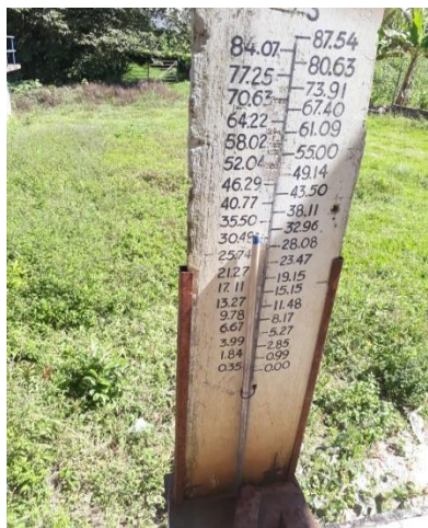
Foto 5. Regleta de medición de caudal
