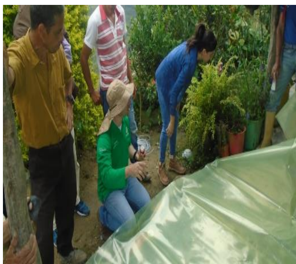
Foto 12. Instalación del ombligo del biodigestor
