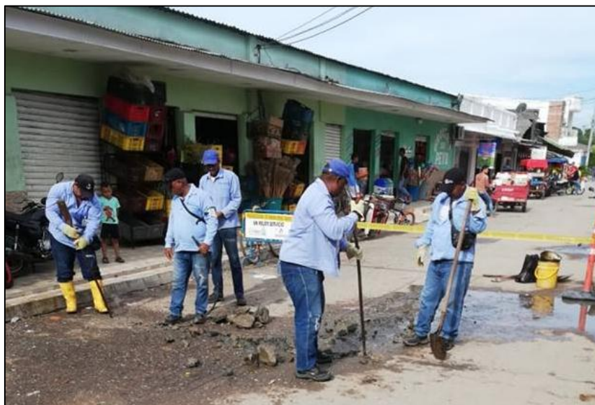
Figura 10. Fontaneros realizando recambio de tuberías Fuente. Pasante del proyecto del proyecto
