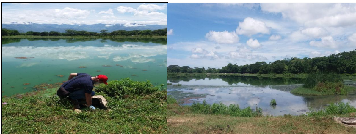
Figura 13. Lagunas de estabilización STAR municipio de Curumani Fuente. Pasante del proyecto del Proyecto
