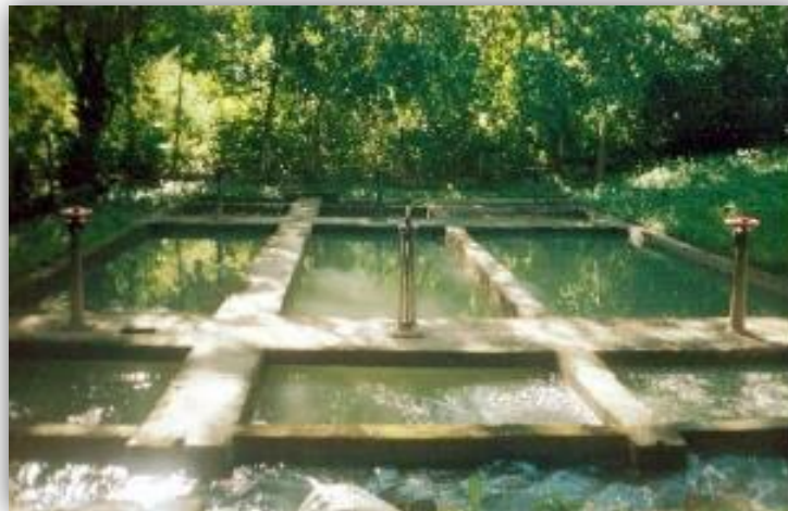
Fotografía 4. Desarenador 2. Fuente: ESPA.
