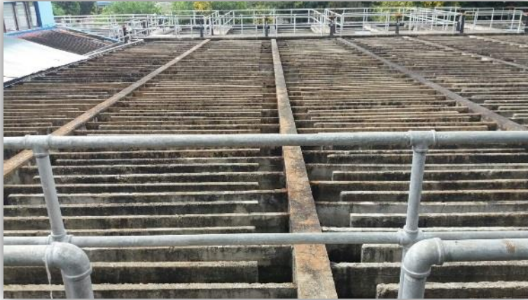
Fotografía 8. Floculadores de flujo horizontal. Fuente: Autora de la pasantía.
