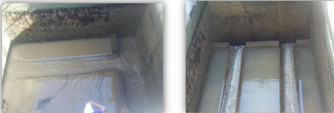
Fotografía 17. Retrolavado de los filtros. Fuente: Autora de la pasantía.
