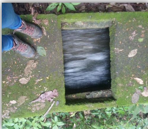
Fotografía 2. Canal de Aducción. Fuente: Autora de la pasantía.
