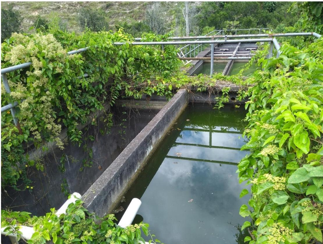
**Figura 23.** PTAR Las Múcuras, en condiciones de abandono y fuera de funcionamiento por fallos en el diseño. Fuente: Autor del proyecto, 2019.
