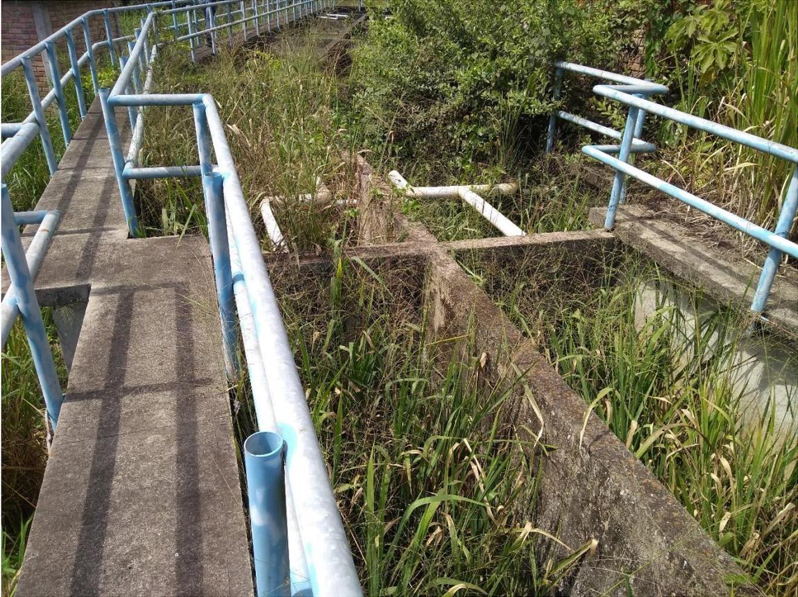
**Nota:** Fotografía de la Planta de Tratamiento de Aguas Residual del municipio de Teorama abandonada, ubicada vía San Calixto, donde se verificó que a pesar de no estar formulada dentro del EOT, se ejecutó su construcción, pero por problemas de diseño, su funcionamiento fue deficiente y se abandonó.
