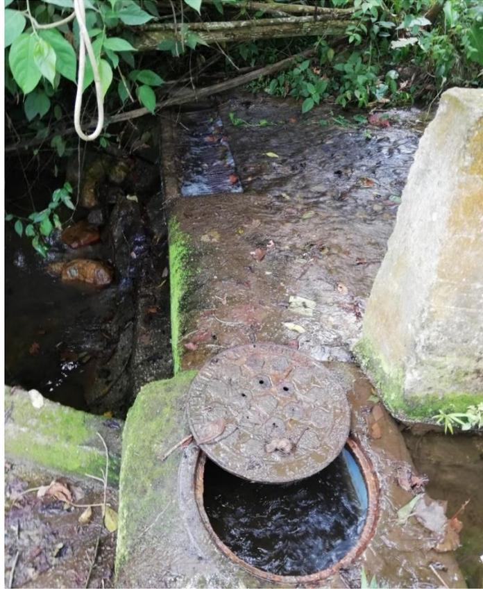
**Figura 21.** Bocatoma de rejillas Cuatro Esquinas y sistema desarenador.
