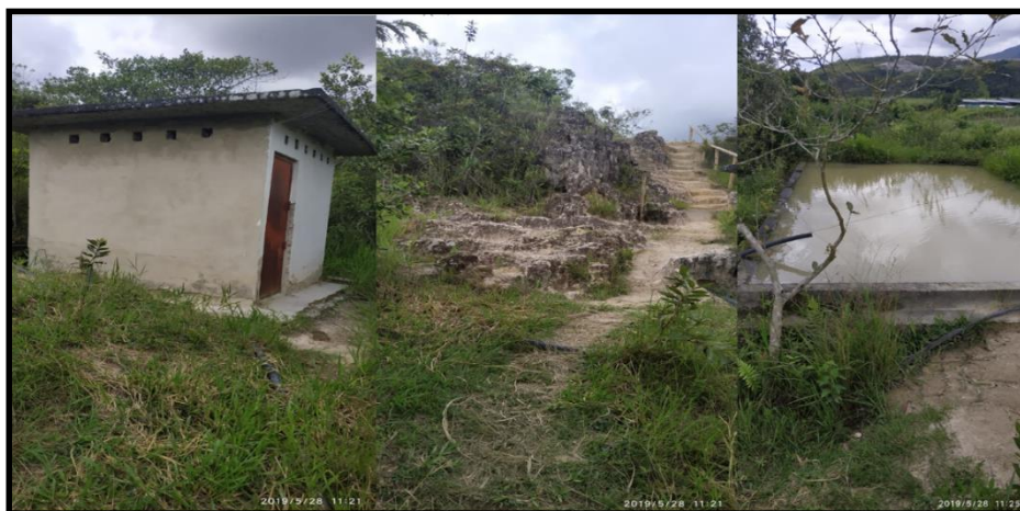
Figura 18. Zona de erosión grado de complicación 1 y 2
