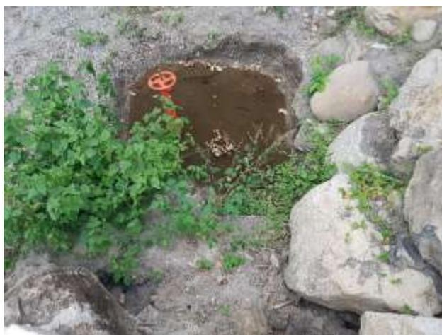
**Ilustración 12** Válvula de apertura y cierre, la cual regula el paso del agua del río Riecito a la planta de tratamiento. (Fuente: autores, 2018)
