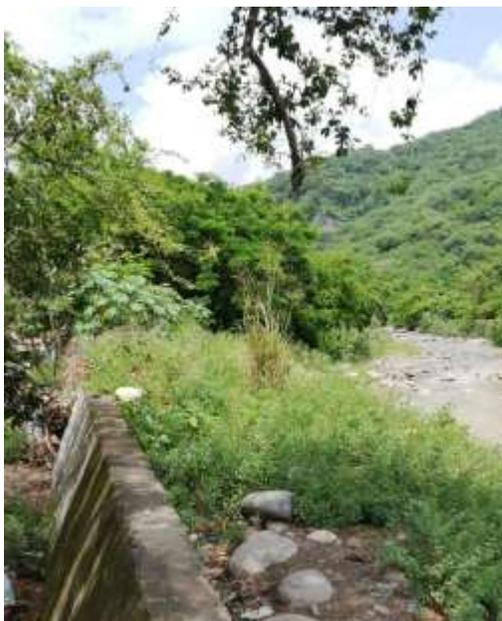
**Ilustración 32** Muro de contención en el barrio el Baho, el cual impide el desbordamiento del río Riecito en estas zonas (**fuentes**, autores 2019).
