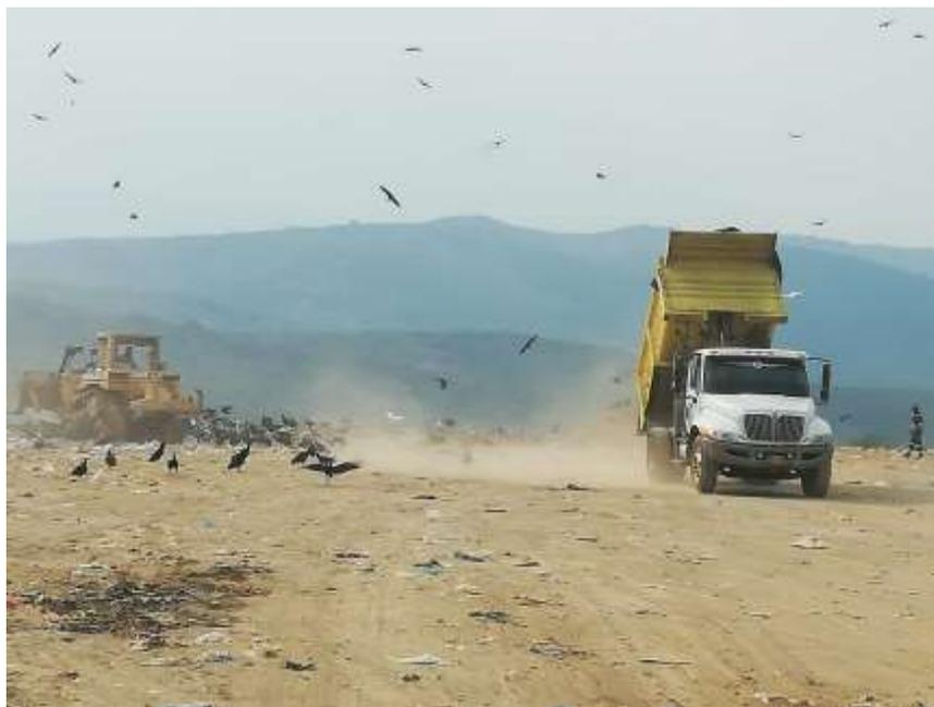
**Ilustración 16.** Descarga de residuos sólidos en el relleno sanitario El Guayabal ubicado en la ciudad de Cúcuta, norte de Santander. (Fuente: autores, 2018)
