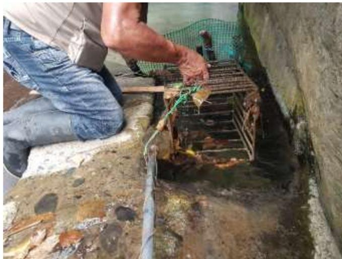
*Ilustración 13* Captación de agua en la quebrada Pailitas, con su sistema de rendijas que ayuda a filtrar el agua. (Fuente: autores, 2018)
