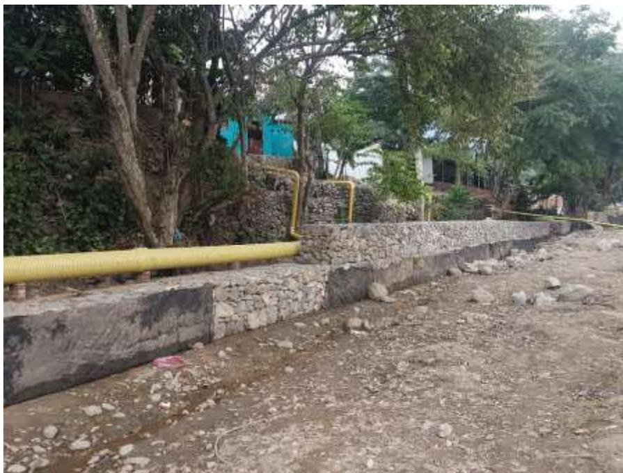
*Ilustración 20* Construcción de un colector para el sistema de alcantarillado en el barrio el Baho.
