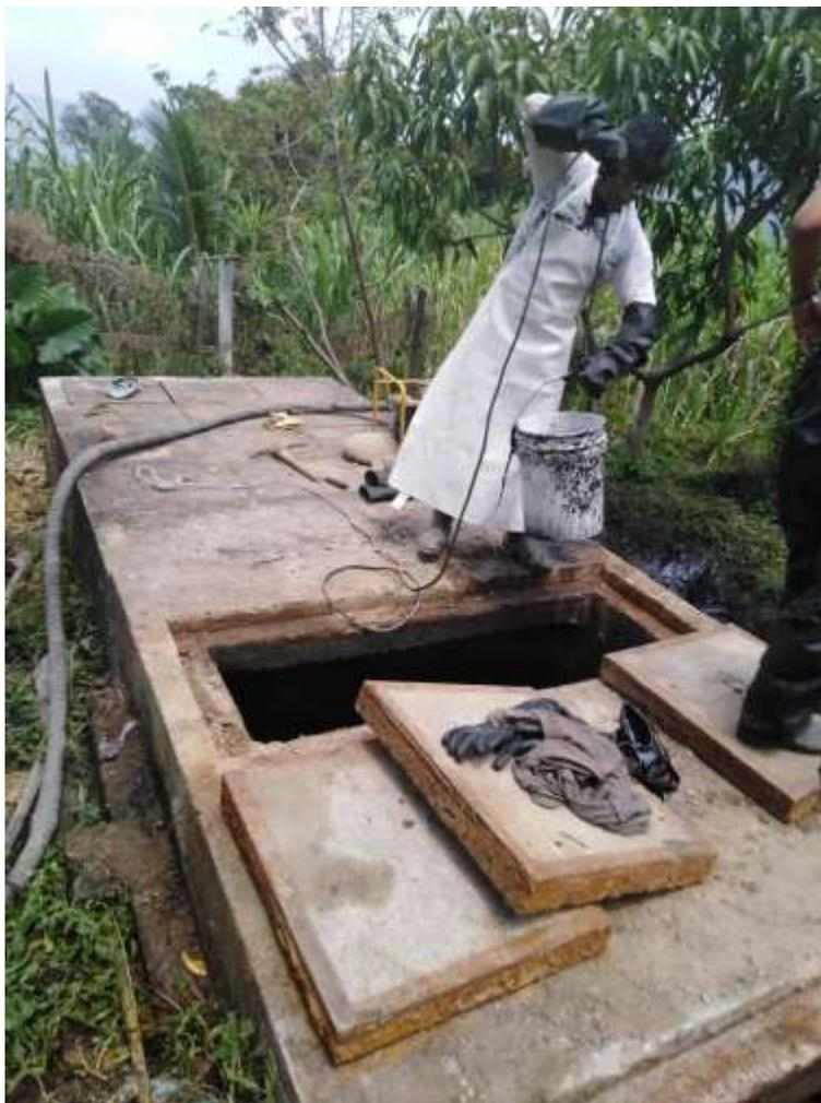
**Ilustración 28** Mantenimiento de uno de los Pozos sépticos de la vereda San Roque. (Fuente: autores 2019).
