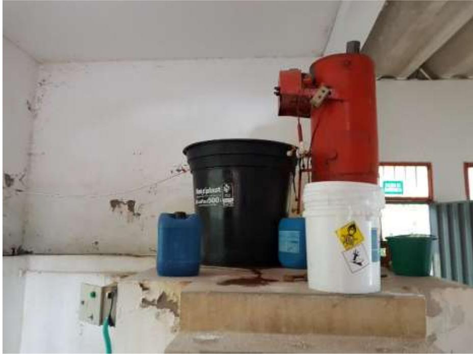
**Nota:** La foto fue tomada el 26 de febrero del 2019. En la imagen se puede observar el tanque usado para la dosificación y adición del sulfato de aluminio con el fin de preparar el agua para la sedimentación. Fuente: autores, 2019.
