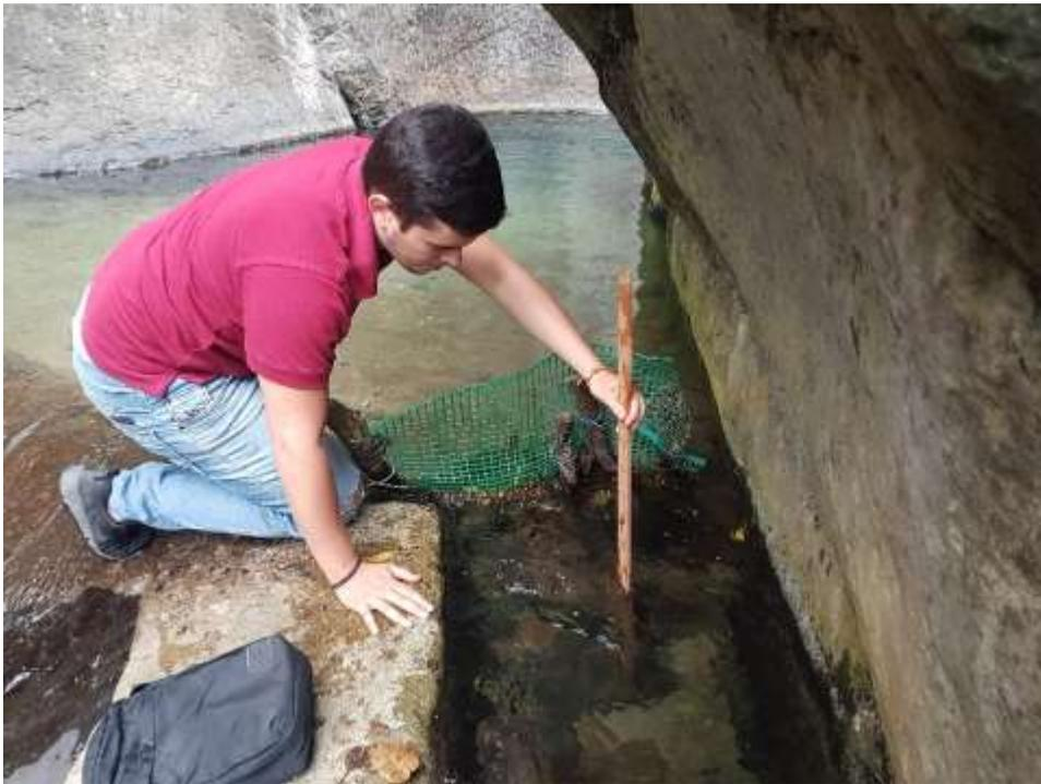
**Nota:** La foto fue tomada el 27 de febrero del 2019. En la imagen se observa al estudiante Jean Lázaro realizando una revisión al estado actual de las rejillas de filtración de la captación ubicada en la quebrada Pailitas. Fuente: autores, 2019.
