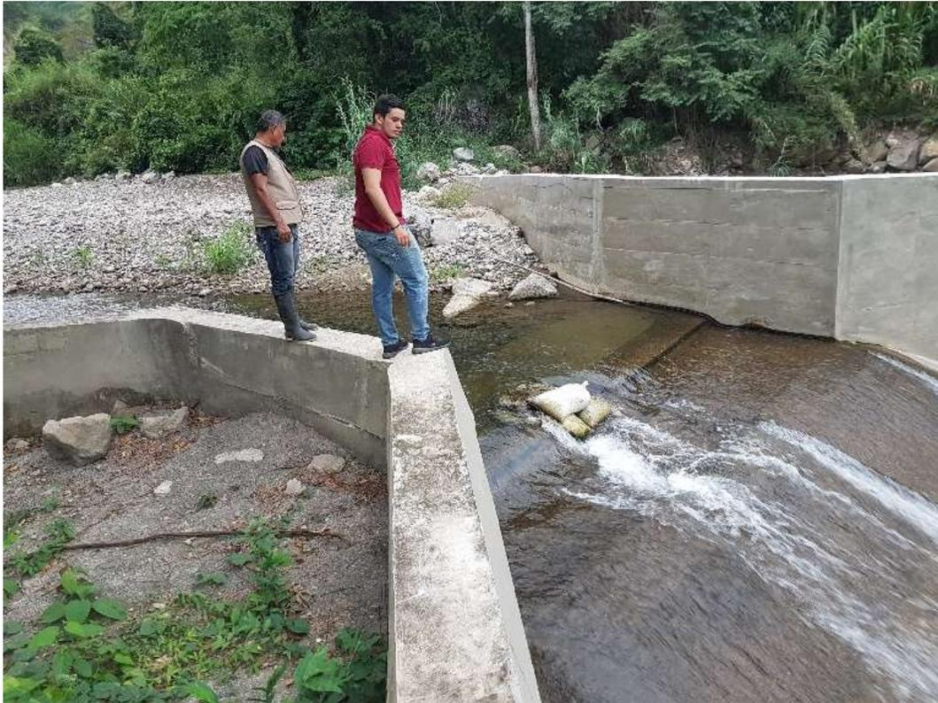
**Nota:** La foto fue tomada el 27 de febrero del 2019. En la imagen se observa al estudiante Jean Lázaro realizando una revisión al estado de la canaleta tipo Parshall de la captación ubicada en río Riecito, la cual se usa para darle presión al agua, y así llegue al tanque de almacenamiento. Fuente: autores, 2019.
