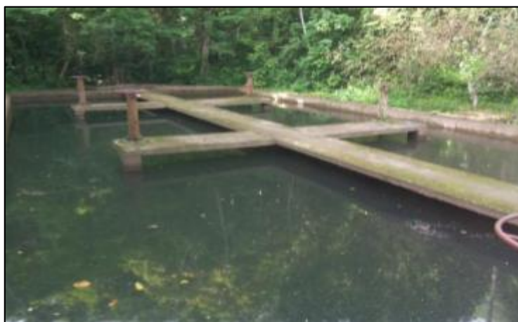
Figura 6. Desarenadores Planta tratamiento de Agua potable
