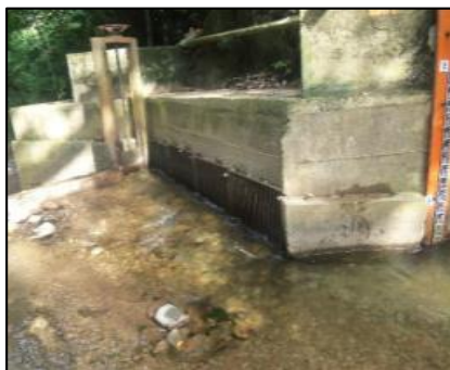
Figura 5. Captación quebrada Buturama
