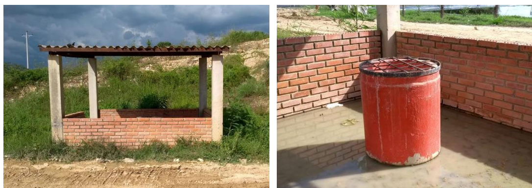
Fotografía 6. Pozos de venteo de gases.
