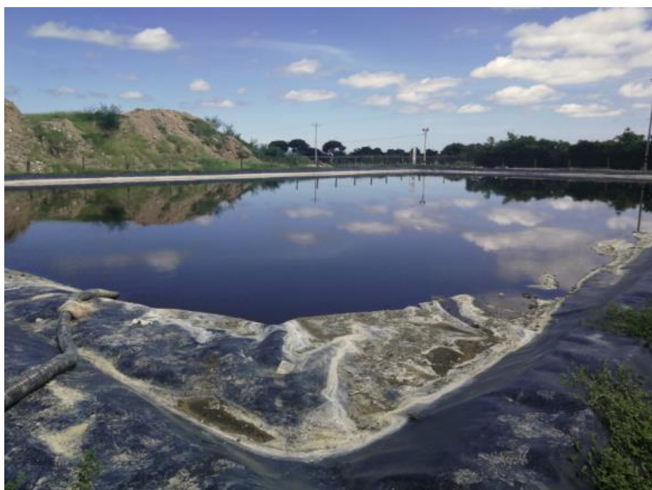
Fotografía 4. Piscinas de Lixiviado
