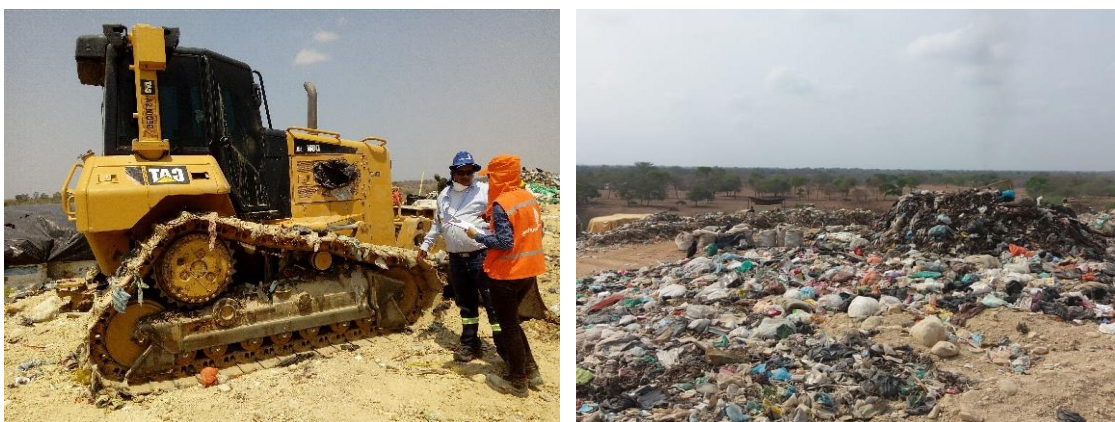
Fotografía 3. Compactación de los residuos.
