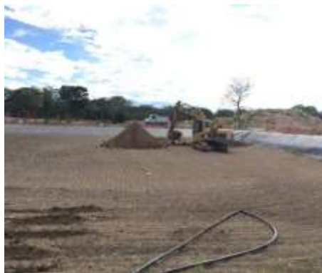
Ilustración 11 Inicio de la formación de biopilas
