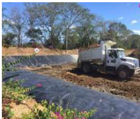
Ilustración 3 Aplicación de capa de suelo préstamo
