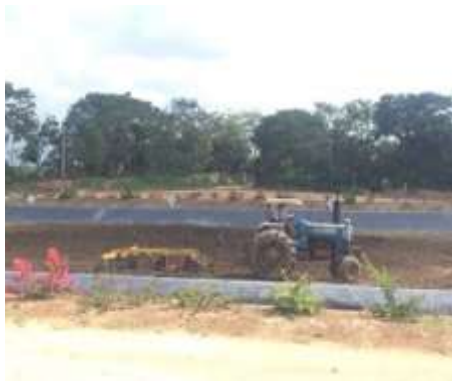
Ilustración 5 Inicio de arado del suelo contaminado
