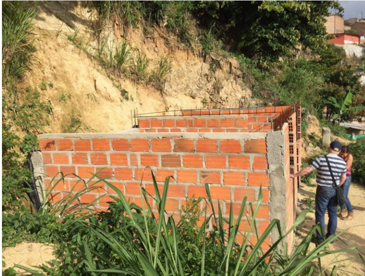
Fotografía 9. Construcción en zona de riesgo crítico
