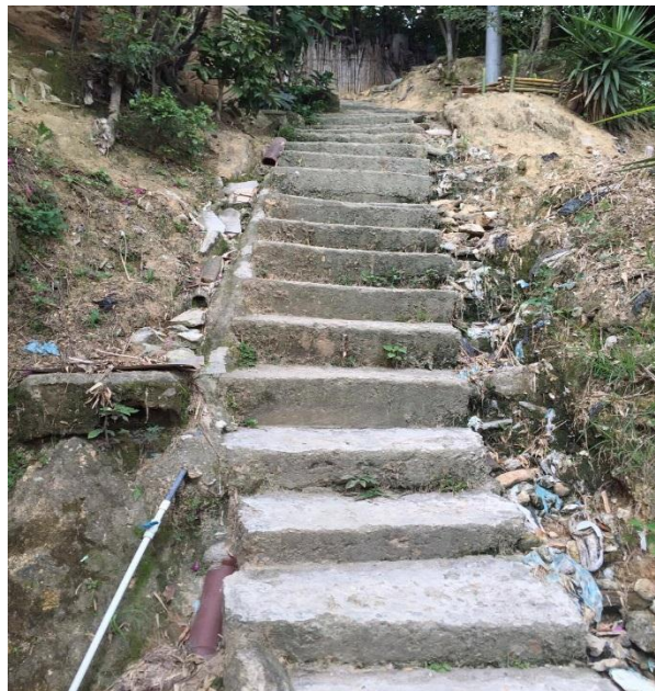
Fotografía 16. Escalinatas, reducen la velocidad de las aguas lluvias previniendo la escorrentía
