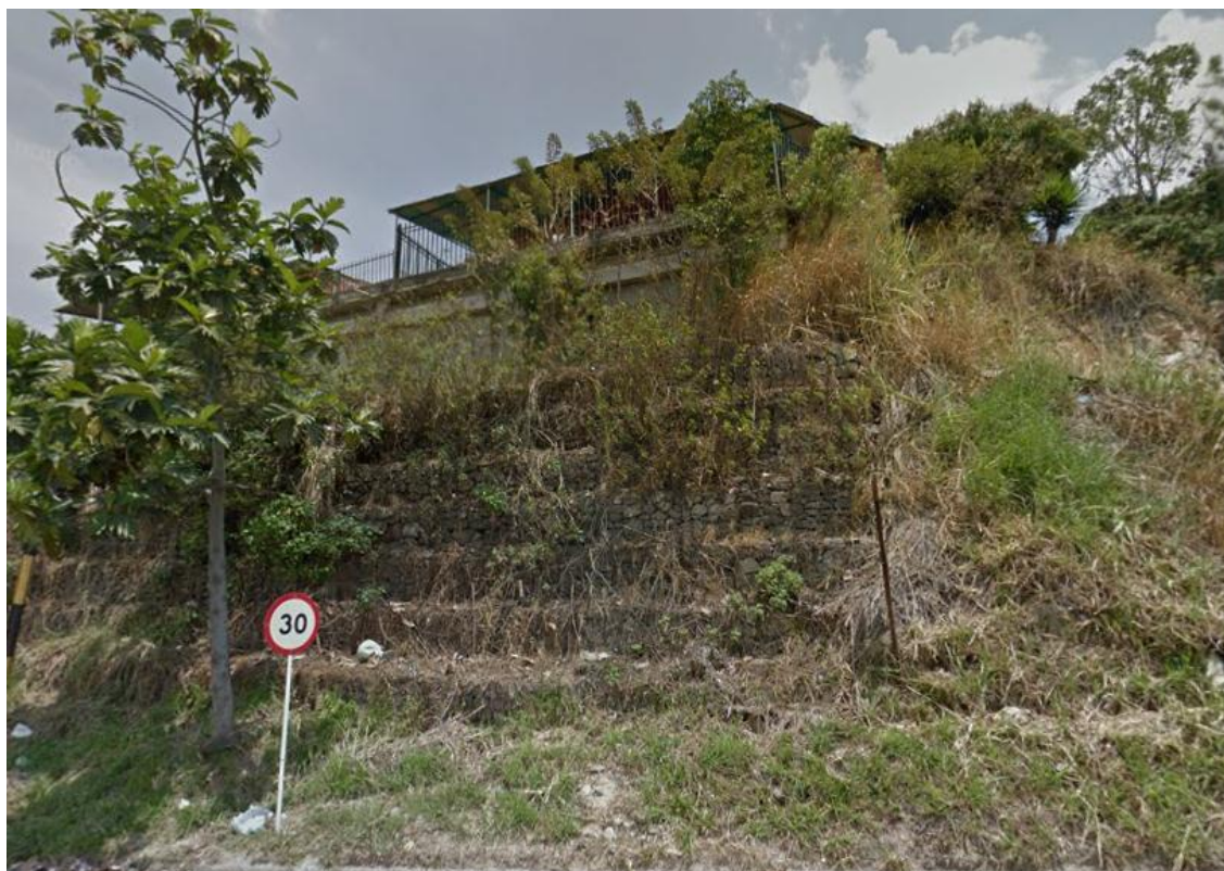
Figura 23. Vivienda construida sobre la zona de ladera del barrio los fundadores, fuente. Autores
