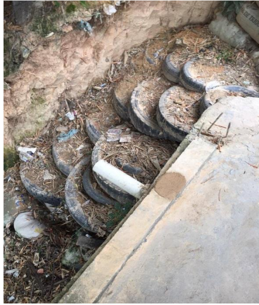
Fotografía 13. Barrera de llantas para evitar escorrentía
