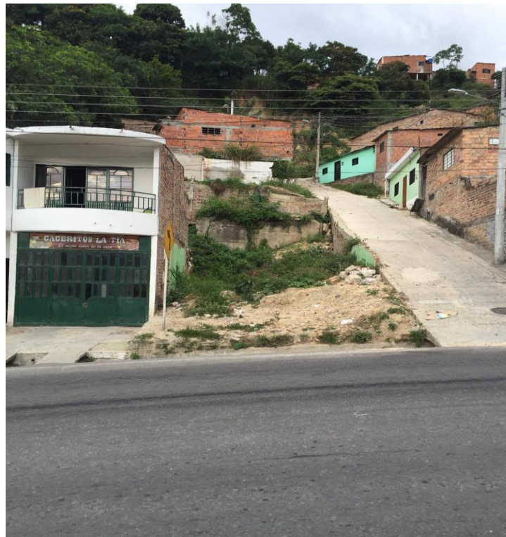
Fotografía 4. Derrumbe de vivienda por construcción inadecuada
