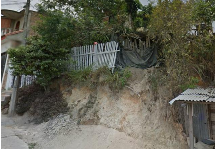
Figura 24. Construcciones inadecuadas que se realizan en el barrio los fundadores. Fuente.
