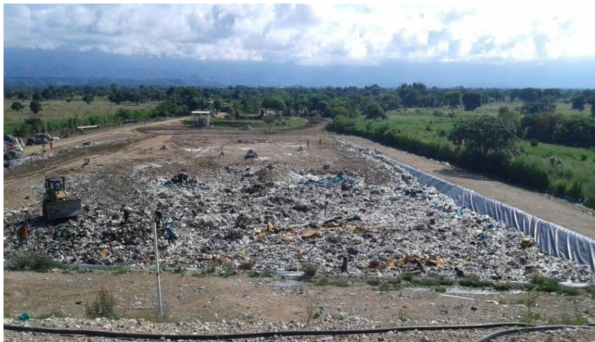
Figura 2. Celda de disposición final del relleno sanitario las Bateas. Fuente: Autor del proyecto.
