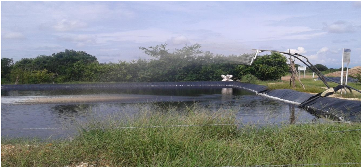
Recirculación en las piscinas de lixiviados.
