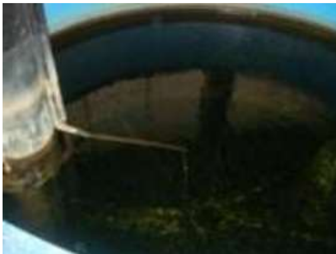
Fotografía 14 Tanque de filtro ADAMIUAIN
