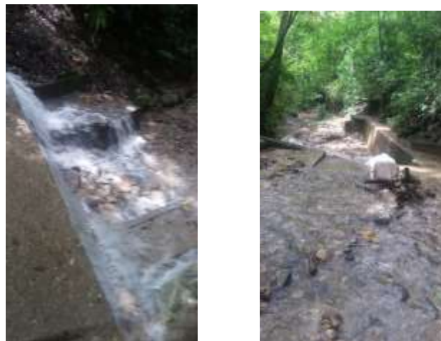
Fotografía 8. Aducción Bocatoma- Desarenador
