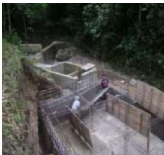
Fotografía 10. Bocatoma y tanque desarenador ADAMIUIAN
