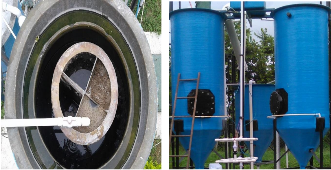
Figura 25. Tanque Sedimentador STARD. Fuente: autor de la pasantía
