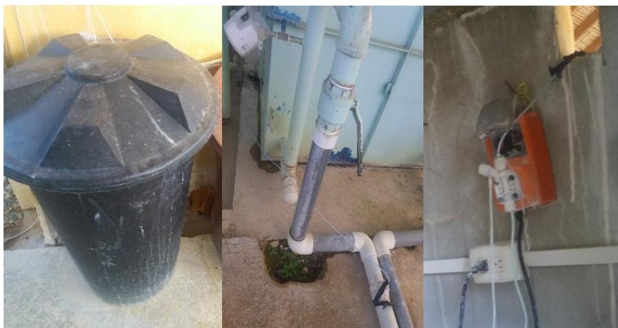
Figura 20, Tanque de Mezcla      Inyección de cloro      Bomba dosificadora
