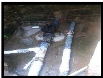
**Diámetros de la tubería:****Sale de 4", se reduce a 3" y a las viviendas llega de 2".**
