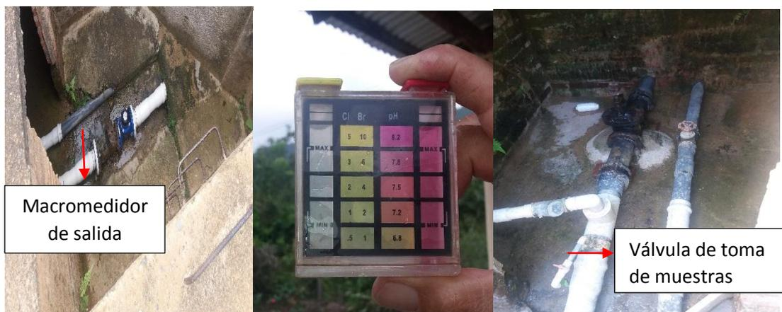
Figura 26. . Macromedidor de salida      Comparador      Válvulas
