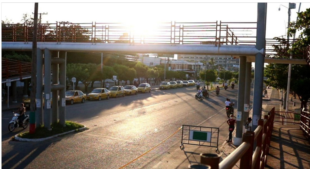
Figura 11 Puente ubicado en el Hospital Regional
