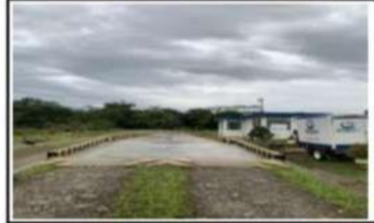
Figura 8. Instalaciones Internas del Relleno Sanitario
