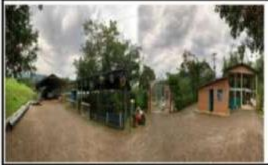
Figura 7. Instalaciones del Relleno Sanitario
