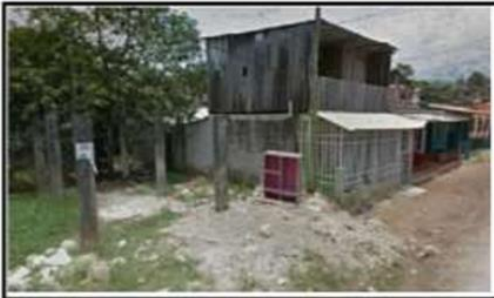
Figura 3. Residuos de Construcción en obras Abandonadas
