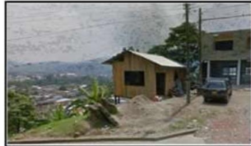
Figura 4. Residuos de Demoliciones
