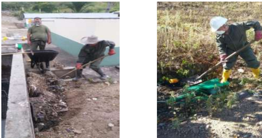
Figura 12. Residuos sólidos enterrados
