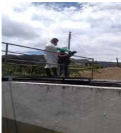
Figura 7. Revisión tanque aireación
