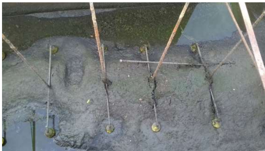
Figura 10. Mantenimiento del tanque
