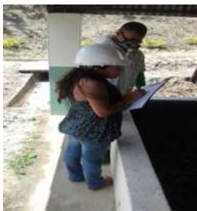
Figura 8. Revisión tanque secado de lodos
