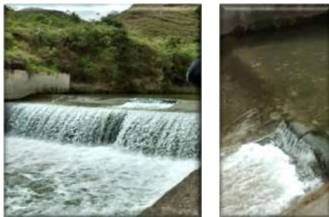
Figura 8 Estructura de la captación río Oroque
