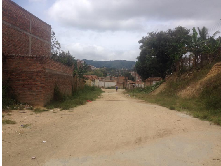
Imagen 8. Estado actual del tramo objeto de recuperación
