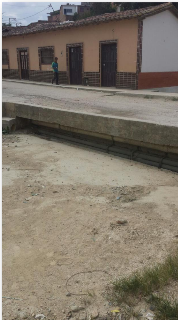
Fotografía 13. Cuenca rio Tejo, Puente San Antonio
