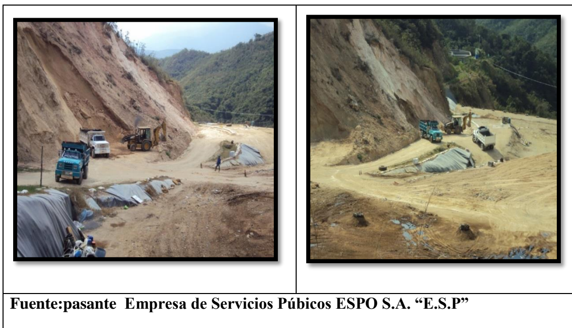
Fotografía 11. Operación y Adecuación del Relleno Sanitario Regional La Madera
