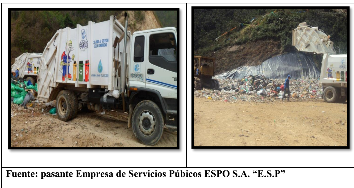
Fotografía 10. Zona de Descargue
