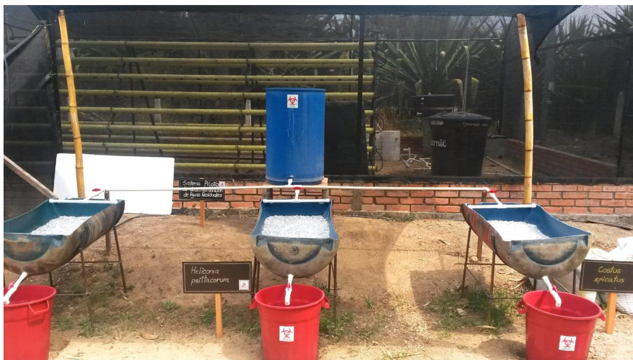
Paso a paso de la construcción del sistema piloto en el vivero de la UFPSO.
