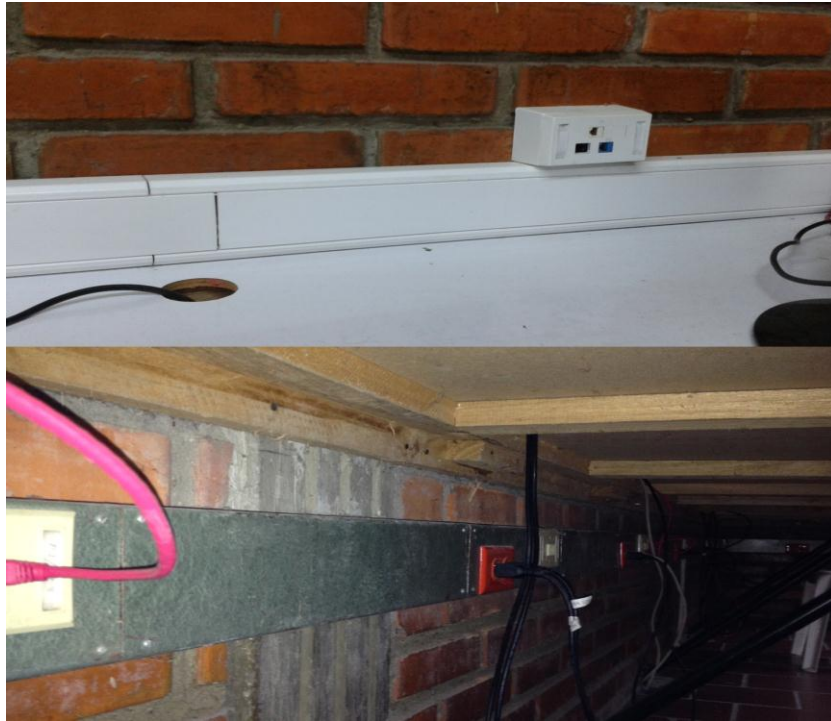
Figura 20. Canalizado Horizontal
