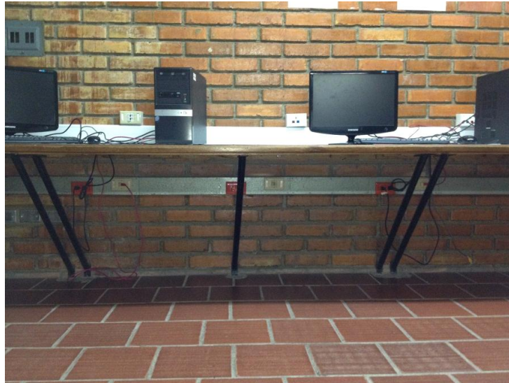
Figura 24. Canalizado Horizontal
