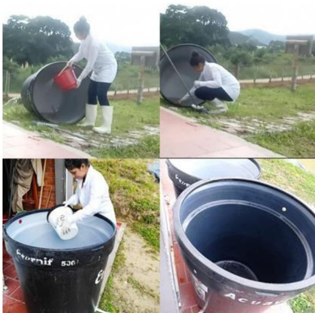
Figura 7. Desinfección de los tanques
