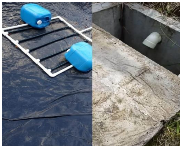
Figura 31. Limpieza de parrillas difusoras y caja de agua.
