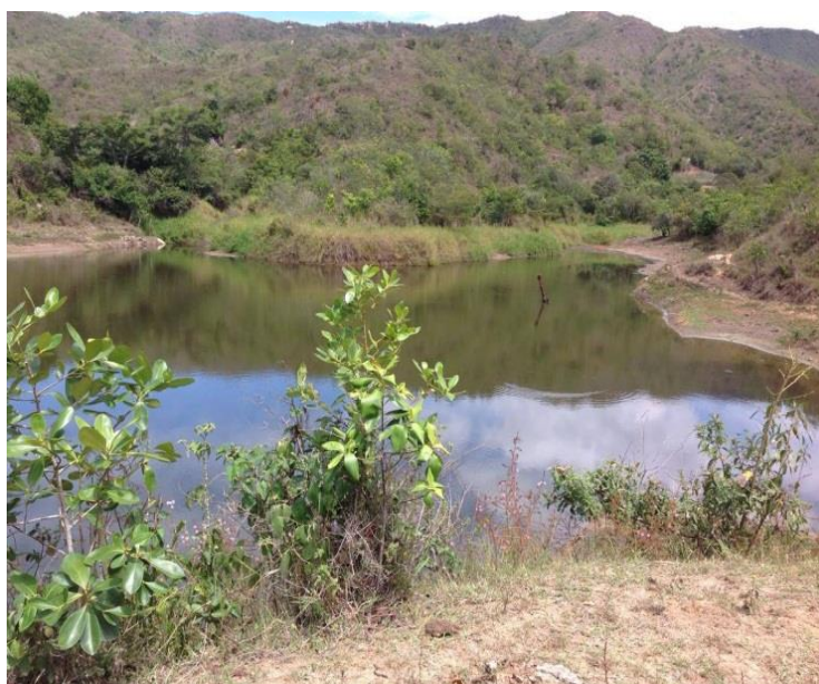
Figura 16. Reservorio. Fuente: Autores del proyecto
