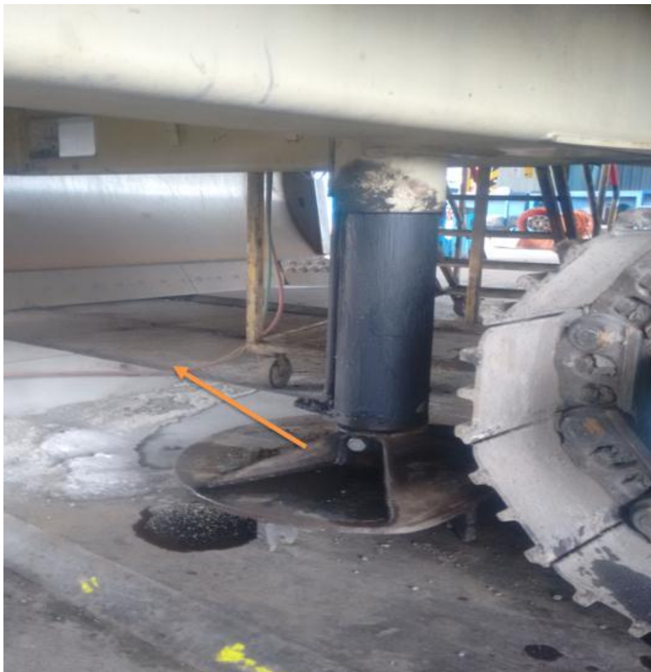
Imagen 17. Zapata de nivelación
